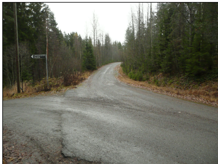
Tie uusittu ja pengerretty suurelta osin. Lintukalliontie 3 kohteen kohdalta
