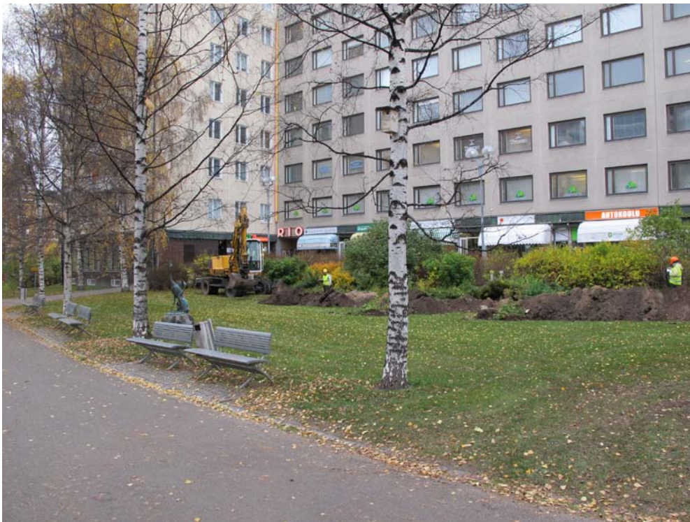
Kuva 3. DG2714:11 Kaivanto sijoittui puiston pohjoispuolelle ja myötäili pensasaluetta.
