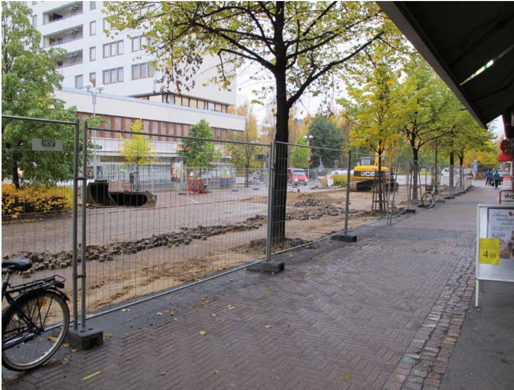
Kuva 1. DG2715:1. Hallituskadun Uusikadun puoleinen pää kuvattuna lounaaseen.
