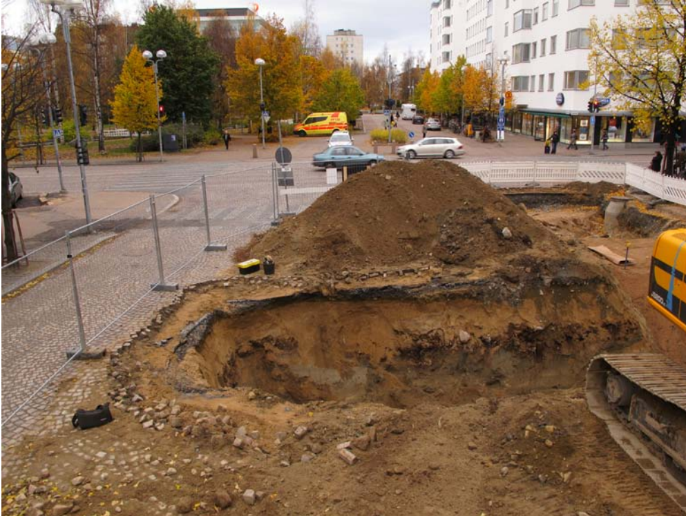
Kuva 8. DG2715:7. Koillis-lounaissuuntaisen (poikittaiskaivanto) vesijohtokaivannon luodeprofiilia. Profiilissa näkyy n. 4 m pituudelta vanhempaa purku-/tasoitekerrosta, jonka jälkeen kerros häviää ja tilalle tulee moderni purkukerros (kaivannon lounaispää).
