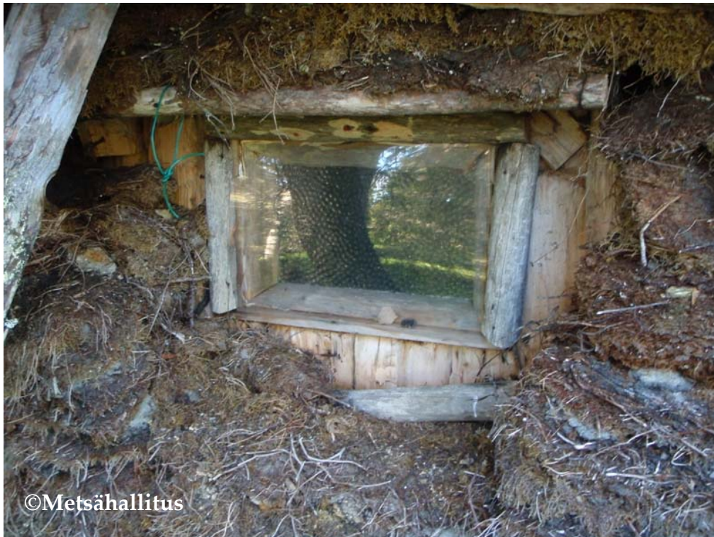
Kuva 3. Sarvolan kämppä. Kämpän ikkuna.
