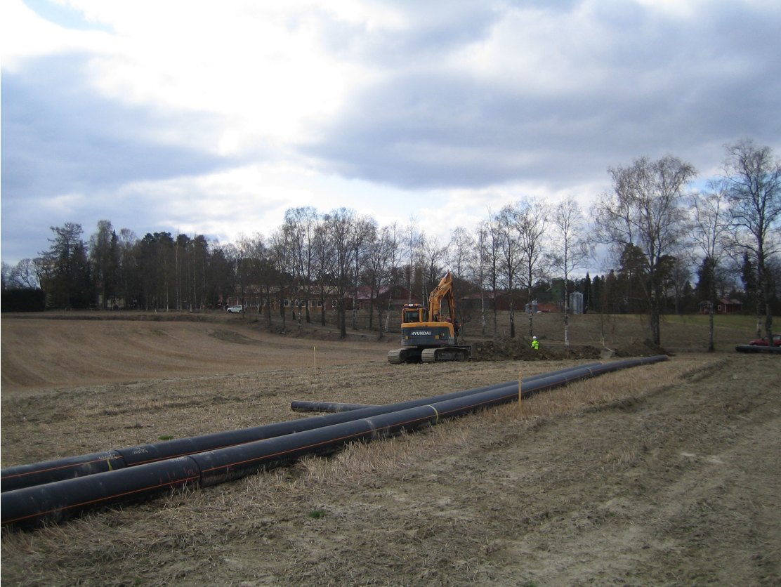
1. Kaivutyötä kaivannon alkupäässä. Taustalla Liuksialan kartano(DK8/KYY).
