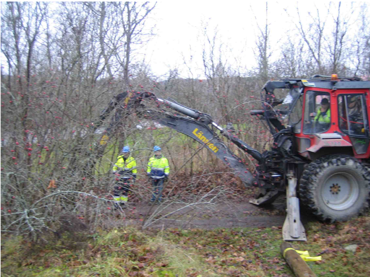
Kuva 1. Uuden pylvään pystytyskuopan kaivamista pihatien viereen.
