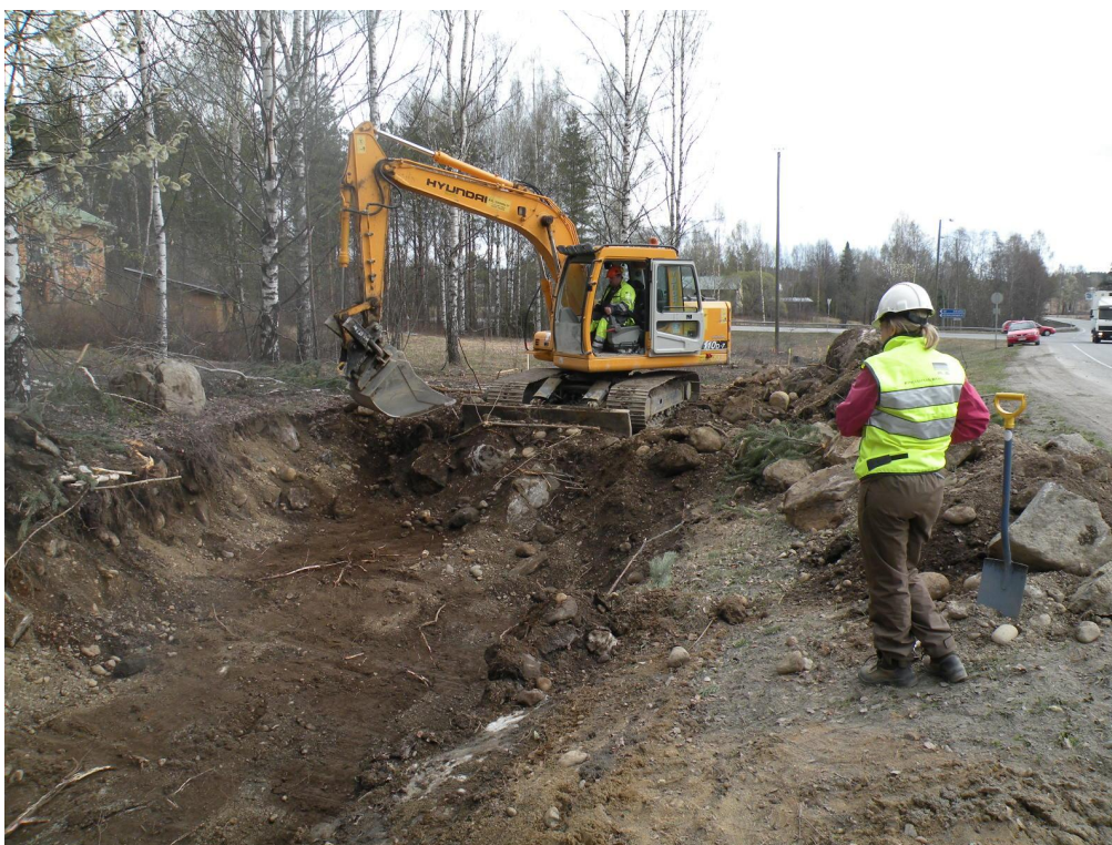
Kuva 1. Pintamaata poistetaan koneellisesti kaivausalueilta A-C. Kuvattu länsilounaasta. (Huutijärvi 2011/kuva 3, KYY 82:1, Kirsi Luoto/Pirkanmaan maakuntamuseo)
