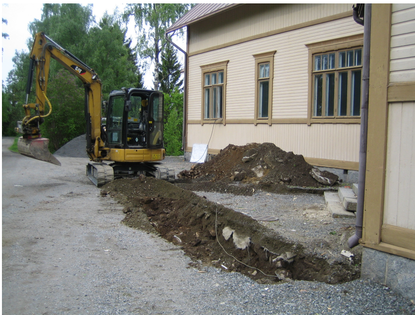
Kuva 2. Sadevesiviemärikaivanto (K4) pappilan edustalla. Pintasoran alta pilkottaa suodatinkangas.
