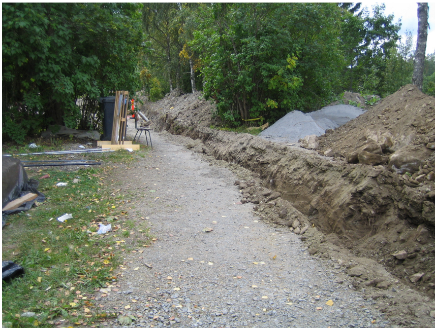
Kuva 3. Kaukolämpölinja (K5) kaivettuna Rovastintieltä pappilan pihaan.
