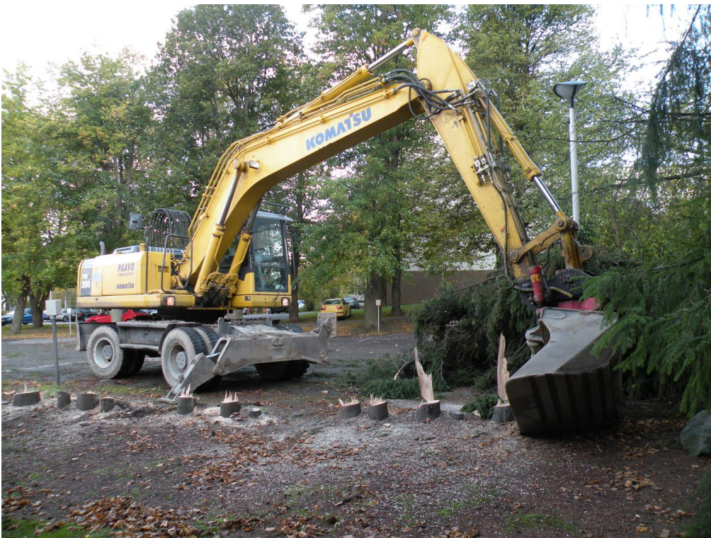
Kuva 2. Kaivinkone poistamassa kantoa. Työkuva. (KYY 95: 2)
