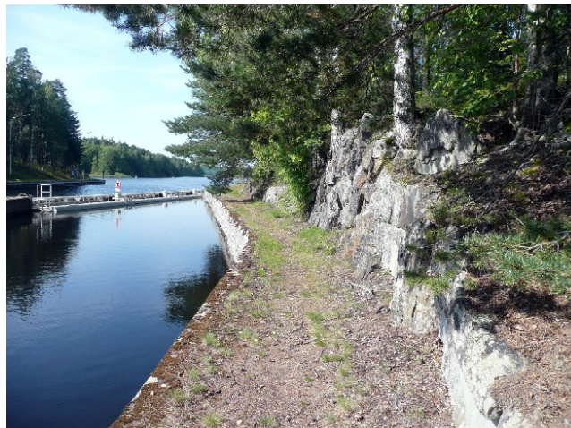
Kuva 7. Kanavarakenteita vanhimman kanavan pohjoispenkereellä. Kanavan reunalla on säilynyt myös useita kiinnitysrenkaita. Kuva idästä.
