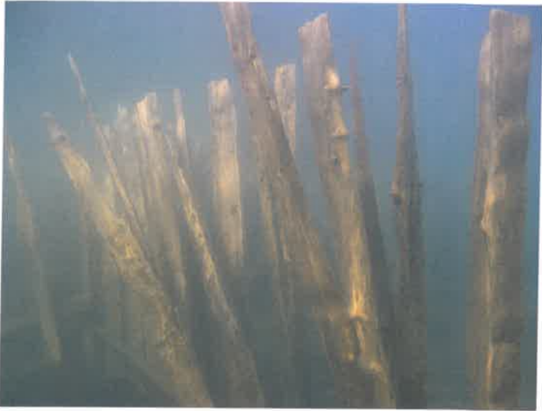
Kuva 29. Johdeaita padon keskivaiheilla. Puut ovat noin 1,5 metriä pitkiä. Kuva: Metsähallitus/Essi Keskinen, luettelonumero: 148.
