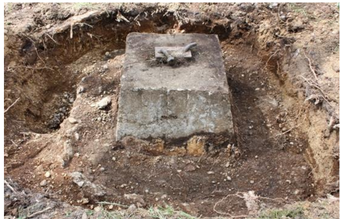
DG2621:18 Koekuopan 3 betonirakenne. Kuopan pohjalla erottuu soran sekainen betonivalu. Sen ja pilarin välissä näkyy vielä valamisen tukena käytettyjen lautojen jäännöksiä. E-W. Kuva Katja Vuoristo.
