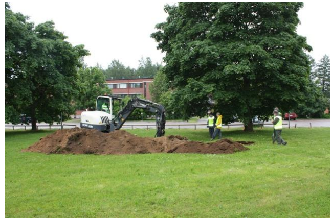
DG2621:1 Koeojaa 1 avataan kaivinkoneella.
