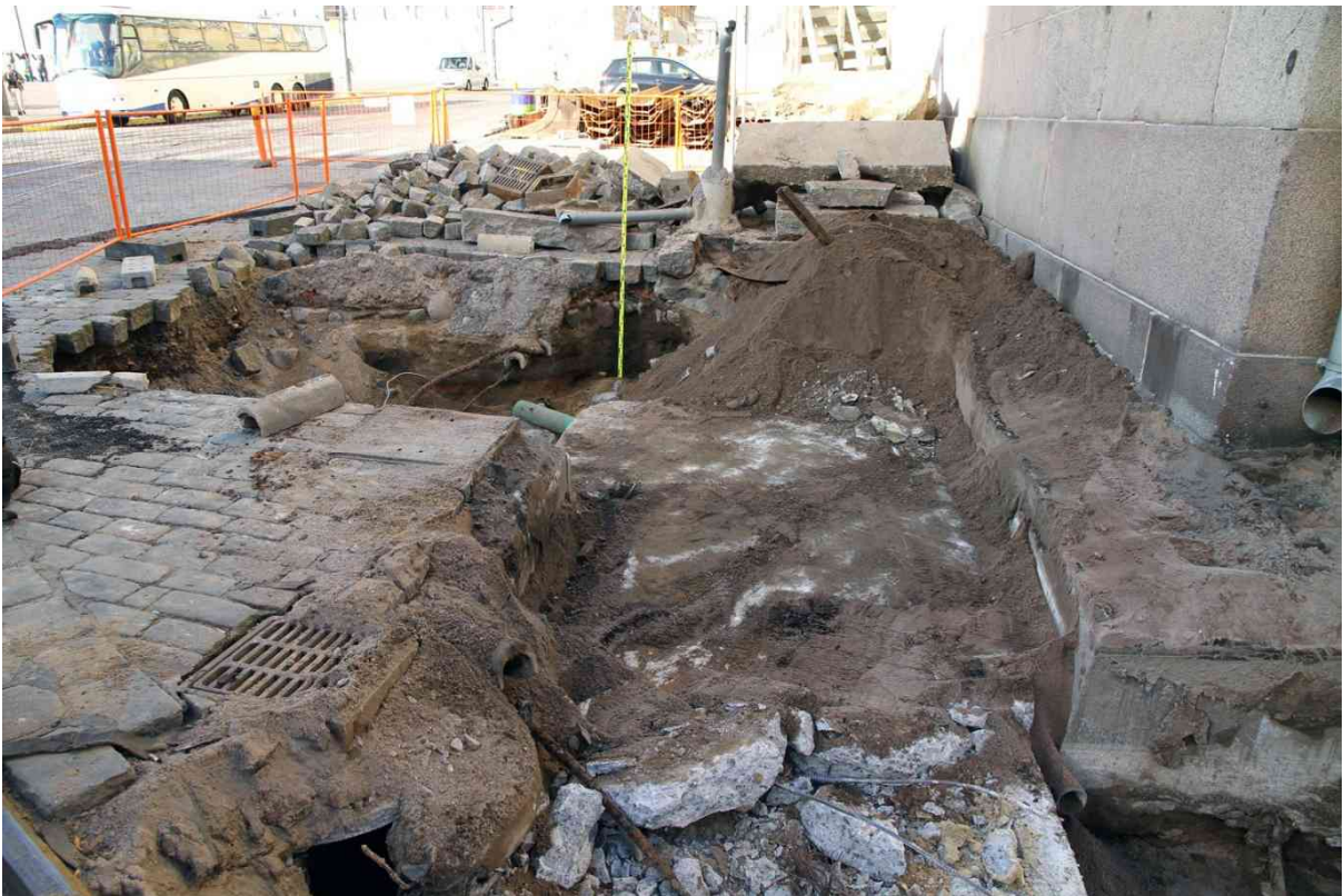
Kaukolämpökaivanto Senaatintorilla. Kohta on ollut auki jo vuosien 1995 ja 1998 tutkimusten aikana. Kuva etelästä. Markku Heikkinen/HKM.
