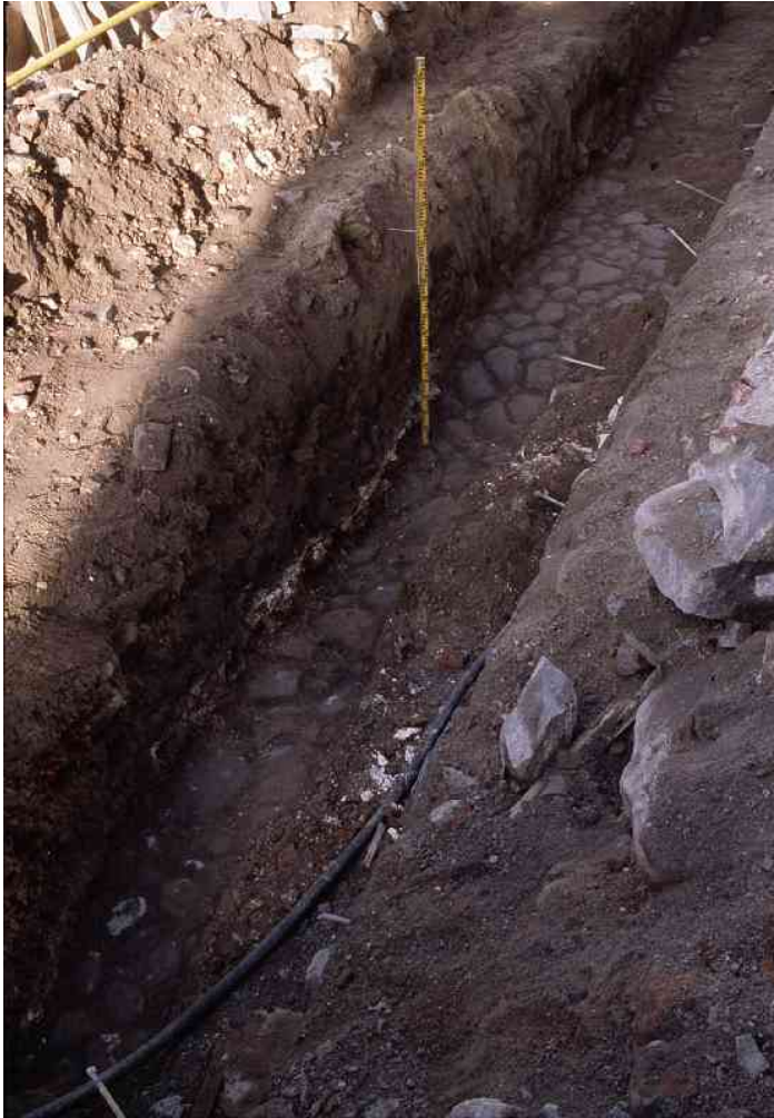
Pääportaikon edustan kiveystä kaivannon pohjalla. Kuva kaakosta. Markku Heikkinen/HKM.
