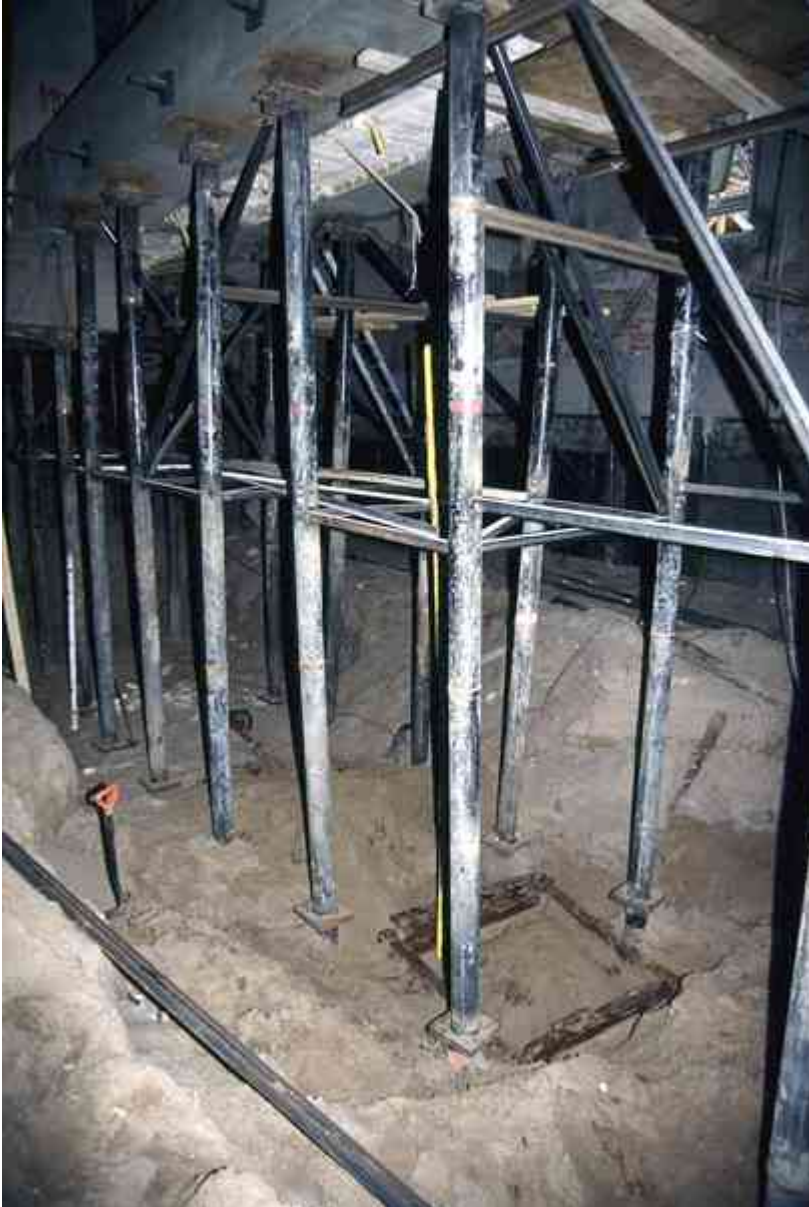
Linna sydänmuurin alta löydetty Suurtorilla sijainnut kaivo, josta oli säilynyt alimmat hirsikerrokset. Sydänmuurin alaosat on poistettu ja rakennus seisoo uusien perustusten varassa. Markku Heikkinen/HKM.
