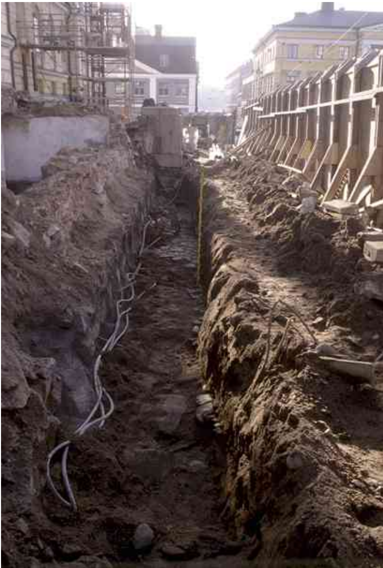
Valtioneuvoston linnan pääportaiden edustan kaivanto. Taaempänä kuopan pohjalla näkyy Suurtorin kiveys. Kuva pohjoisesta. Markku Heikkinen/HKM.
