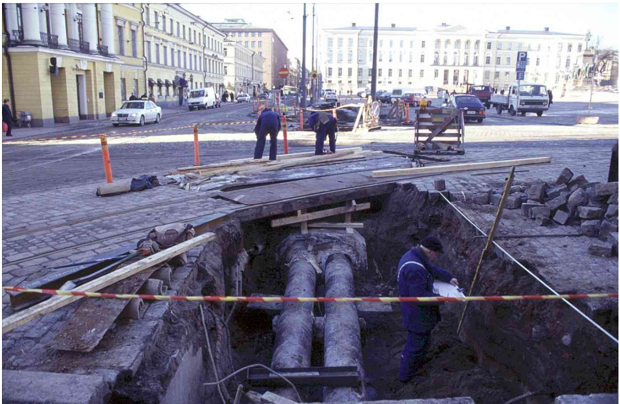
Kaukolämpökaivannon profiilia dokumentoidaan vuonna 1998. Kuva idästä. Markku Heikkinen/HKM.
