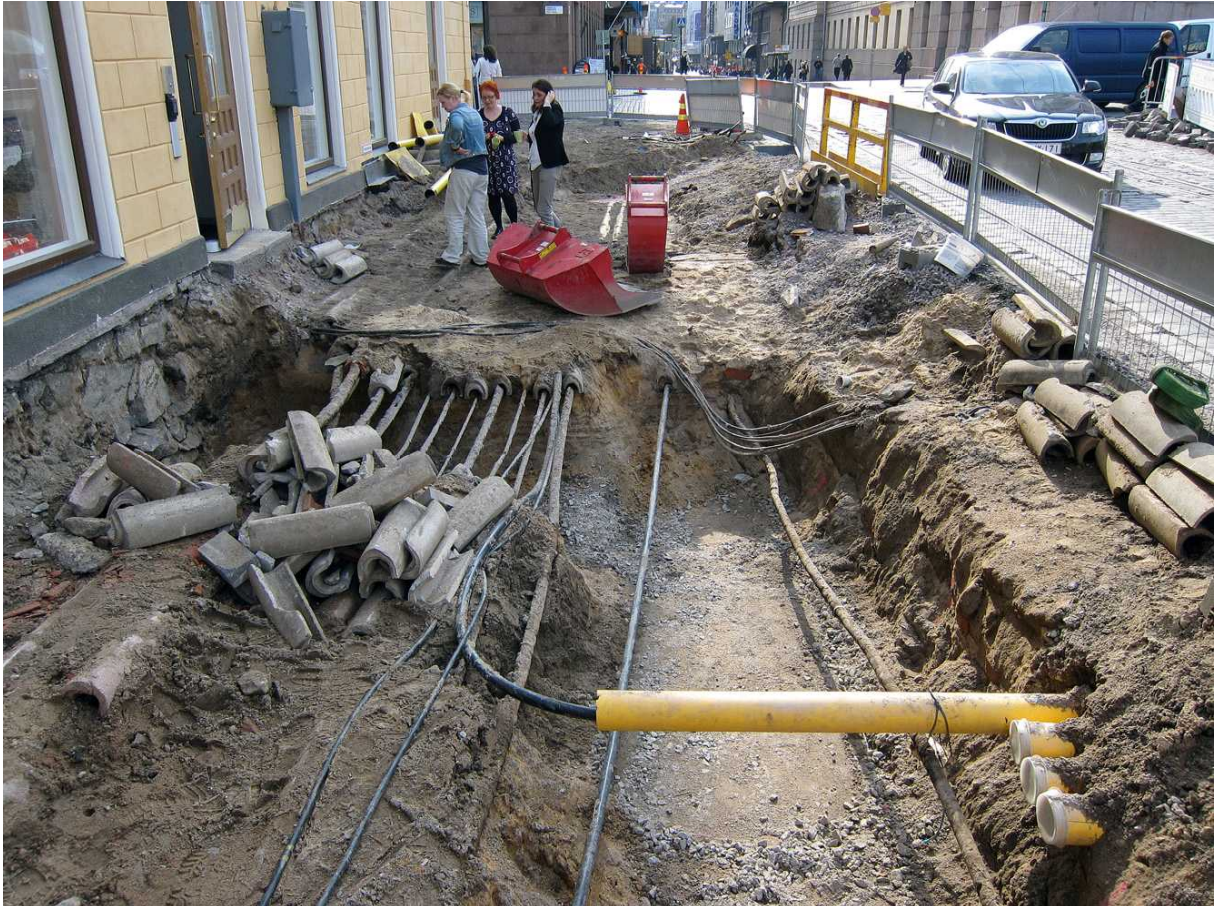
Kiseleffin jalkakäytävä avattuna uuden leveytensä mukaan.
