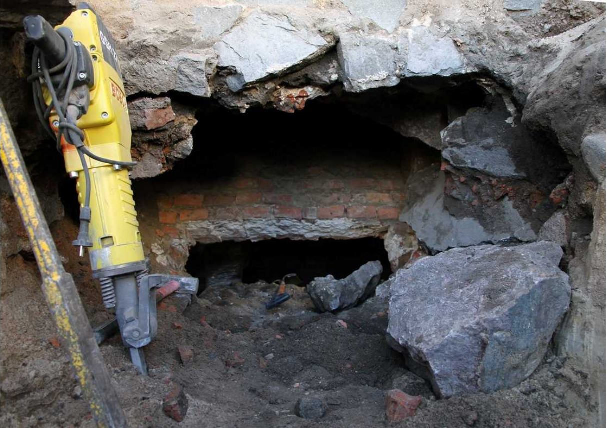
Kuvassa on puhkaistu Kiseleffin pohjoisseinän kiviperustus ja kellaritilan K061 tiiliholvi putkien asennusta varten.
