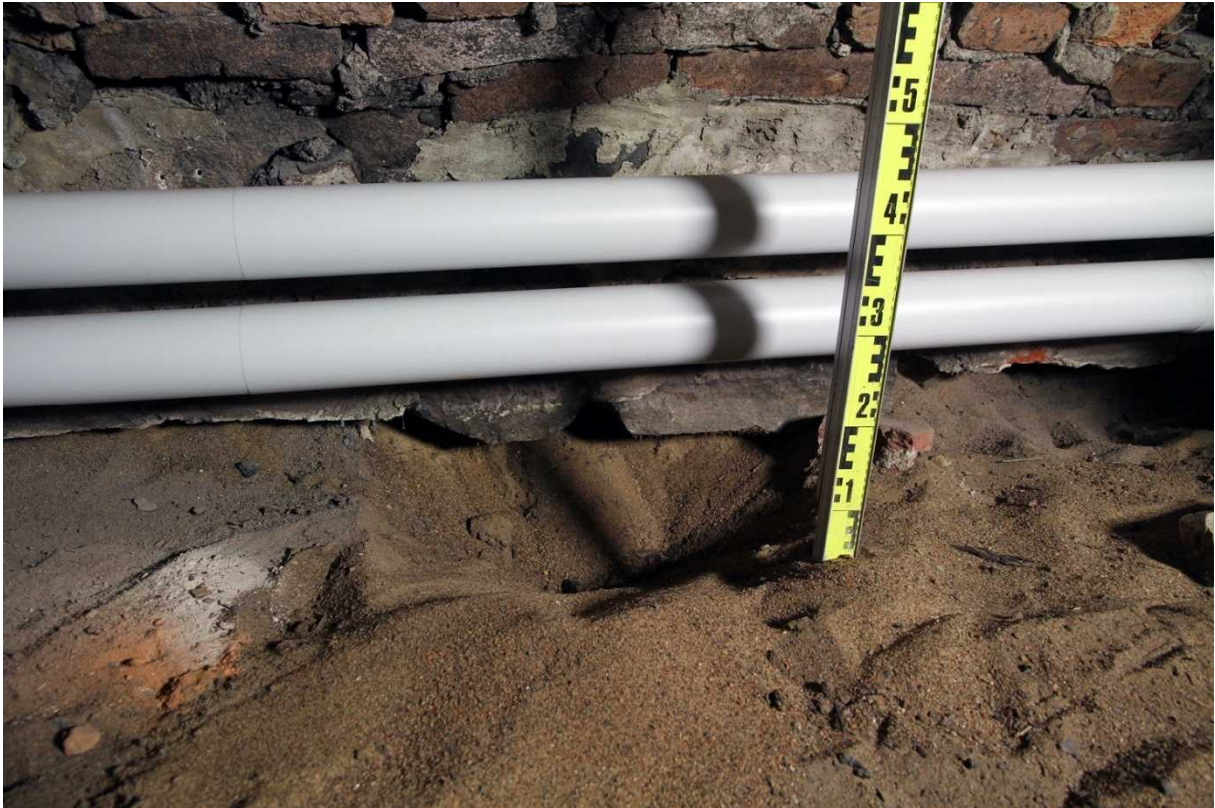
Koepisto tilan S013 perustuskiven viereen. Kivien alla oli löysää hiekkaa, joka alkoi heti valua pois kivien alta.
