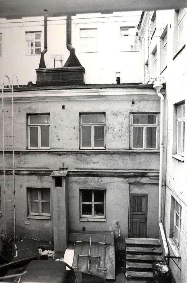
Sunnin piha vuonna 1978. Kuvan alareunan keskellä näkyy vielä portaikko ja sen luukut kellariin S020. Kuva E. Salmela/HKM.
