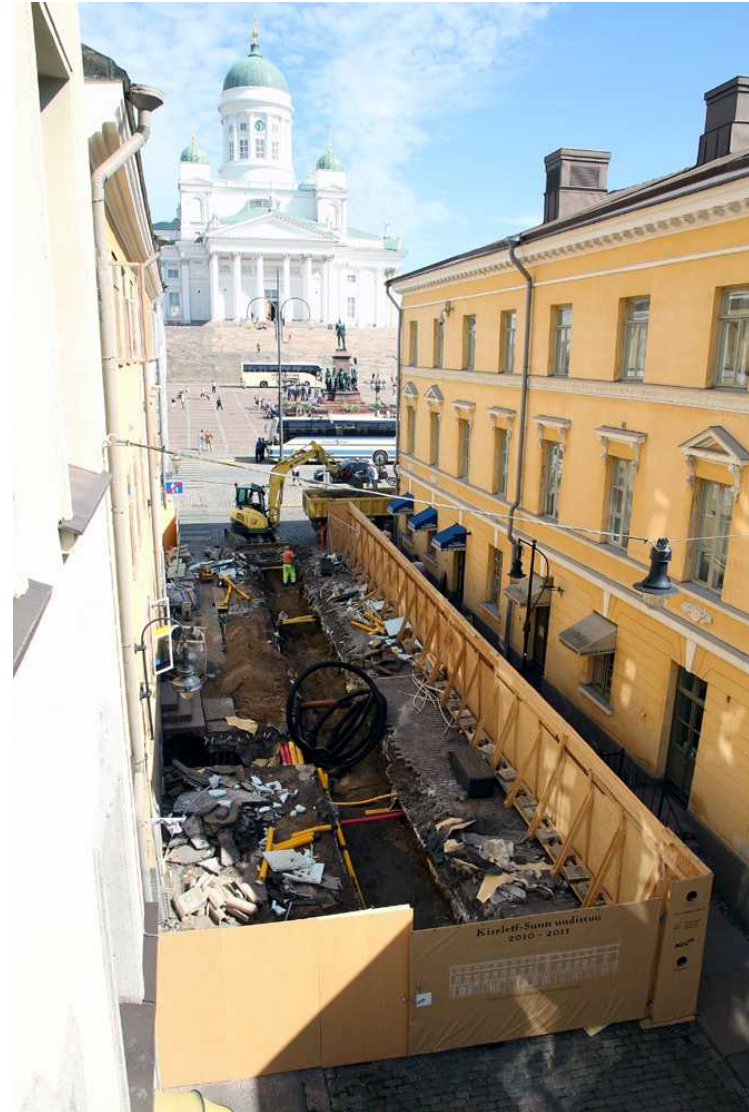
Yleiskuva Sunnin putkikaivannosta Sofiankadulla. Kuva etelälounaasta.
