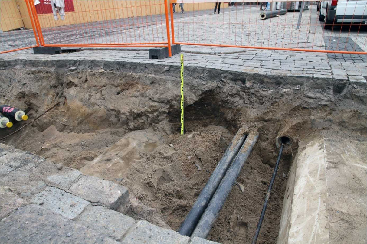
Kaivannon länsilaidalla näkyi täyttömaakerroksia. Kuva on otettu koillisesta.
