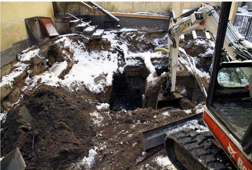
Sunnin pihan pohjoisosa. Vasemmalla näkyy aukko Sunnin läntiseen kellaritilaan S020 seinässä olevan aukon ja tikapuiden kautta ja keskellä uudehkot käyttämättömät tiilirakenteet.
