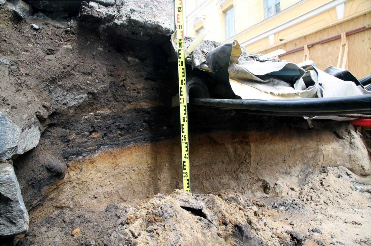
Profiili Sunnin portaikon, kaapeleiden ja katulämmityksen putkien alapuolella.
