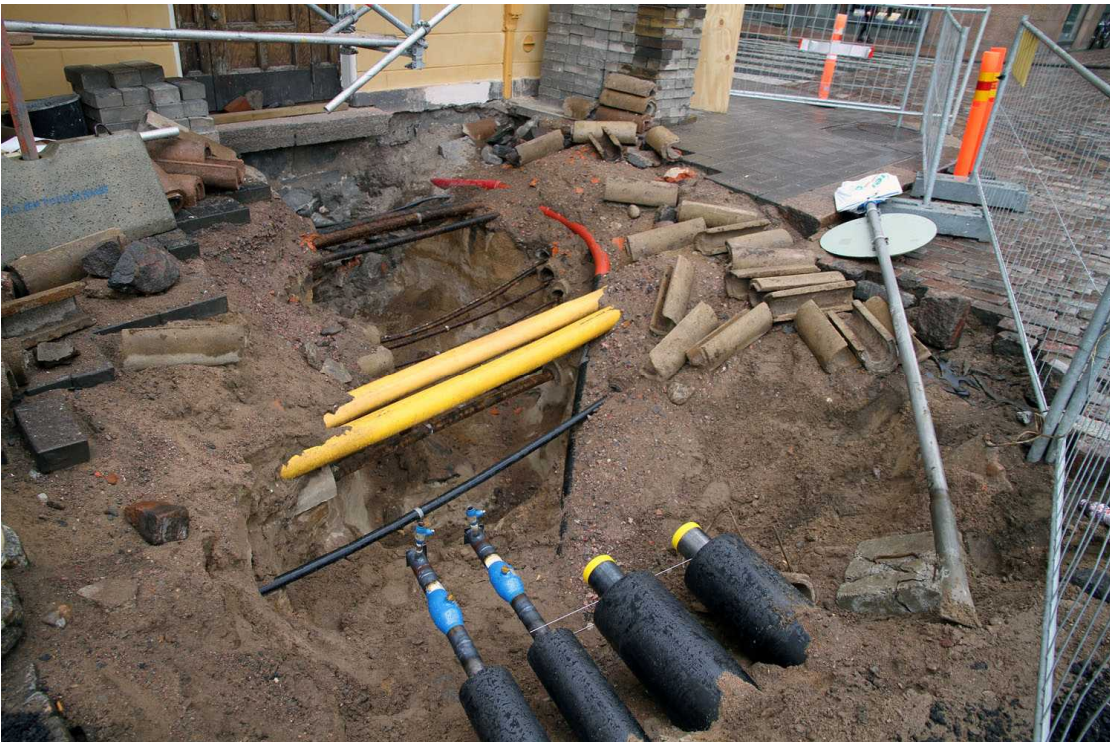
Näkymä kaivannosta Kiseleff-Sunnin luoteiskulmaa kohti koillisesta kuvattuna.
