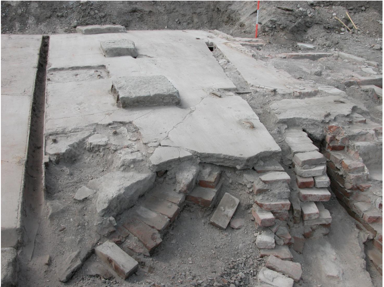
Vasemmassa laidassa massahiomon betonilattian poikki kulkeva rautakouru. Siitä oikeaan betonitason alla kulkevia tiilisiä tunneli- ja kanavarakenteita. Ympyröity laakakiven vierellä oleva tyhjiin tilaan avautuva kolo. Kuvattu länteen. Kuvaaja: Sami Raninen.
