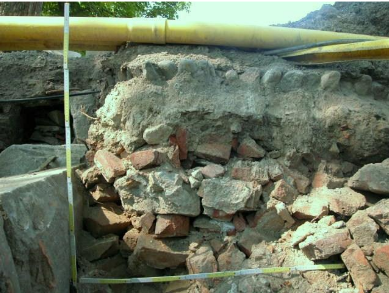
Kuva 32: E-alueen kaivannon profiilia kivimuurin länsiluoteispään pohjoispuolella (kuvan kohta merkitty vihreällä ympyrällä kuvassa 2). Kenttäkiveyksen ja sen asetushiekkakerroksen alla on runsaasti tiiltä sisältävä purku/täyttemaakerros. Vasemmalla kivimuri. Kuvattu länteen. Mittakaavana 2 metrin nivelmitta (100 cm pystysuunta, 100 cm vaakasuunta). Kuvaaja: Sami Raninen.
