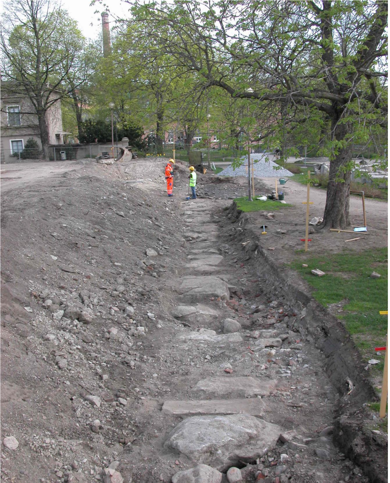
Kuva 17: B-alue kuvattuna pohjoisluoteeseen. Etualalla resentin tukimuurin pohjaa, jonka oikealla puolella tiiltä sisältävä purku/täytemaakerros. Kauempana HuK Anniina Laine ja viheryksikön työntekijä keskustelevat kenttäkiveyksen kohdalla. Taustalla Puutarhakatu ja sen takana häämöttävä Frenckellin jugend-teollisuuskompleksi. Vasemmassa yläaidassa Frenckellin Konttoritalon itäpäätty. A-alue eli puiston yläpiha kaivannon vasemmalla puolella töyrään päällä. Kuvaaja: Sami Raninen.
