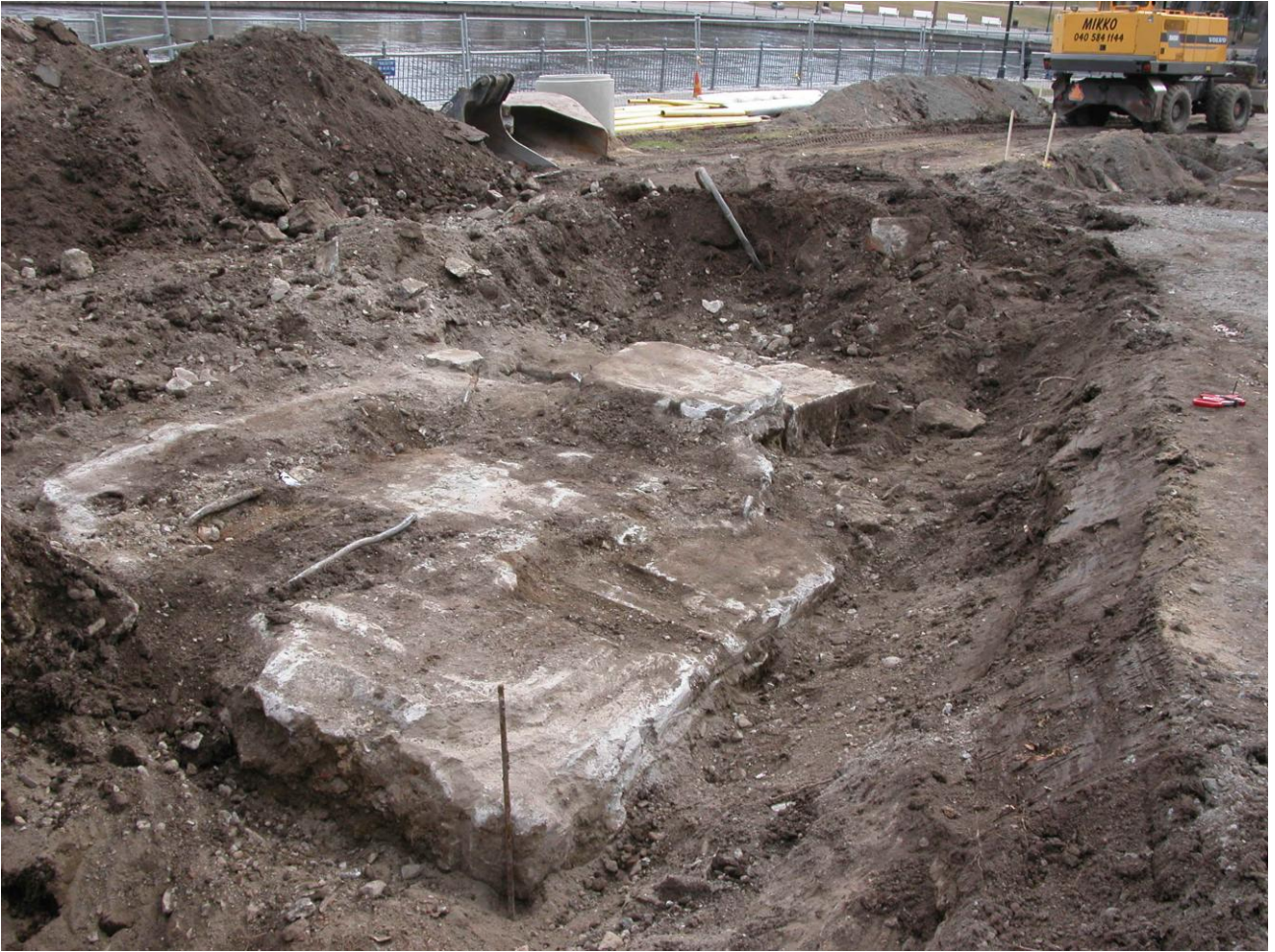
Kuva 40: Massiivinen betonirakenne H1. Kuvattu kaakkoon. Kuvaaja: Sami Raninen.
