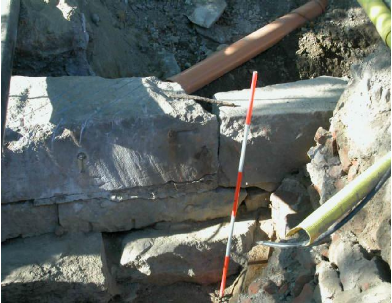
Kuva 29: Rakennekuva kivimuurista. Kuvassa näkyvät kiviä yhdistävä hakarauta, kivistien välinen betonsauma ja porausjäljet keskivivissä olevassa kivessä. Vasemman ylälaidan kivessä (ns. A-kivi) on rautatappeja (pohjoisluoteinen kylki) ja vuonna 2010 tehtyjä sahausuria (ylätaso). Kuvattu lounaaseen. Mittakaavana teikki (värit vuorottelevat 30 cm:n välein). Oikeassa laidassa erottuu profiilissa tiilensekaista purku/täyttemaakerrosta. Kuvaaja: Sami Raninen.
