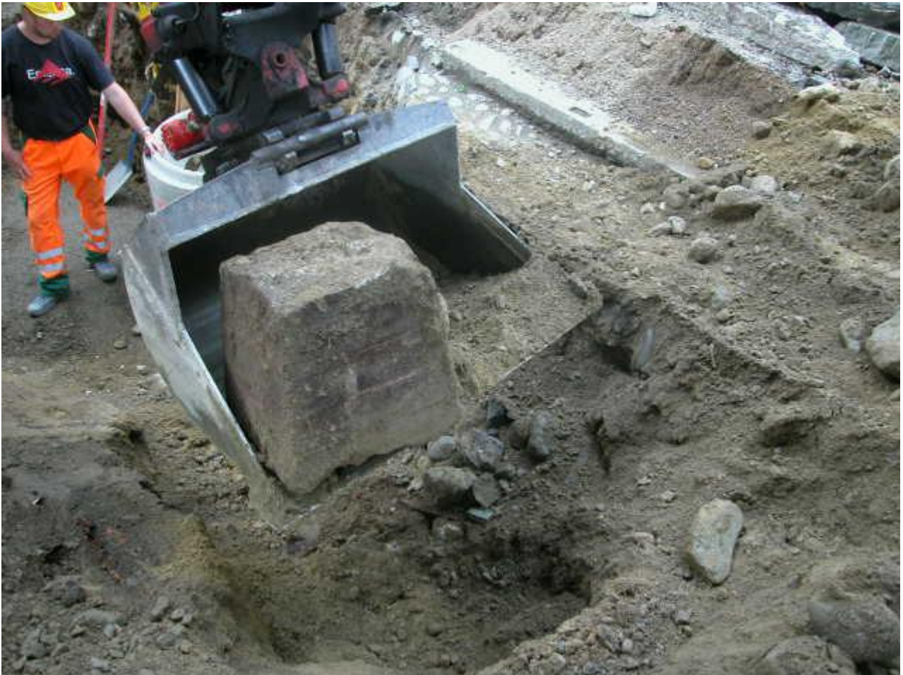
Kuva 36: Betoniesinettä C poistetaan. Vasemmalla kenttäkiveyksen pohjoisosa ja betonilaatta. Kuvattu länsiluoteeseen. Kuvaaja: Sami Raninen.
