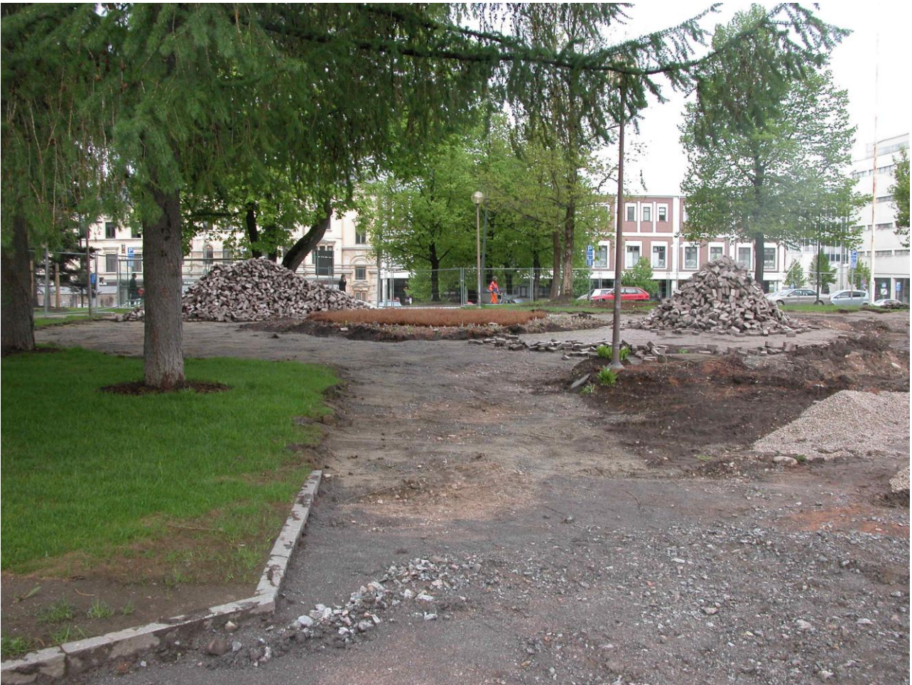
Kuva 1. A-alueen työn alkuvaiheessa. Luvattu länteen. Kuvaaja: Sami Raninen.
