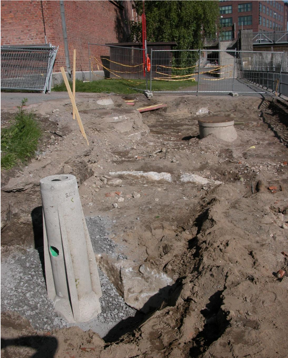
Kuva 59: Rakenne I3 vuonna 2010 asennetun katuvalaisimen jalan vierellä. Kuvattu pohjoiseen. Pystysuorassa seinässä oleva kolo on jäänyt murskeen peittoon. Pohjoisnuolen pituus 50 cm. Taustalla Frenckellin koskisiipi, Satakunnansilta ja Finlaysonin kompleksi. Kuvaaja. Sami Raninen.
