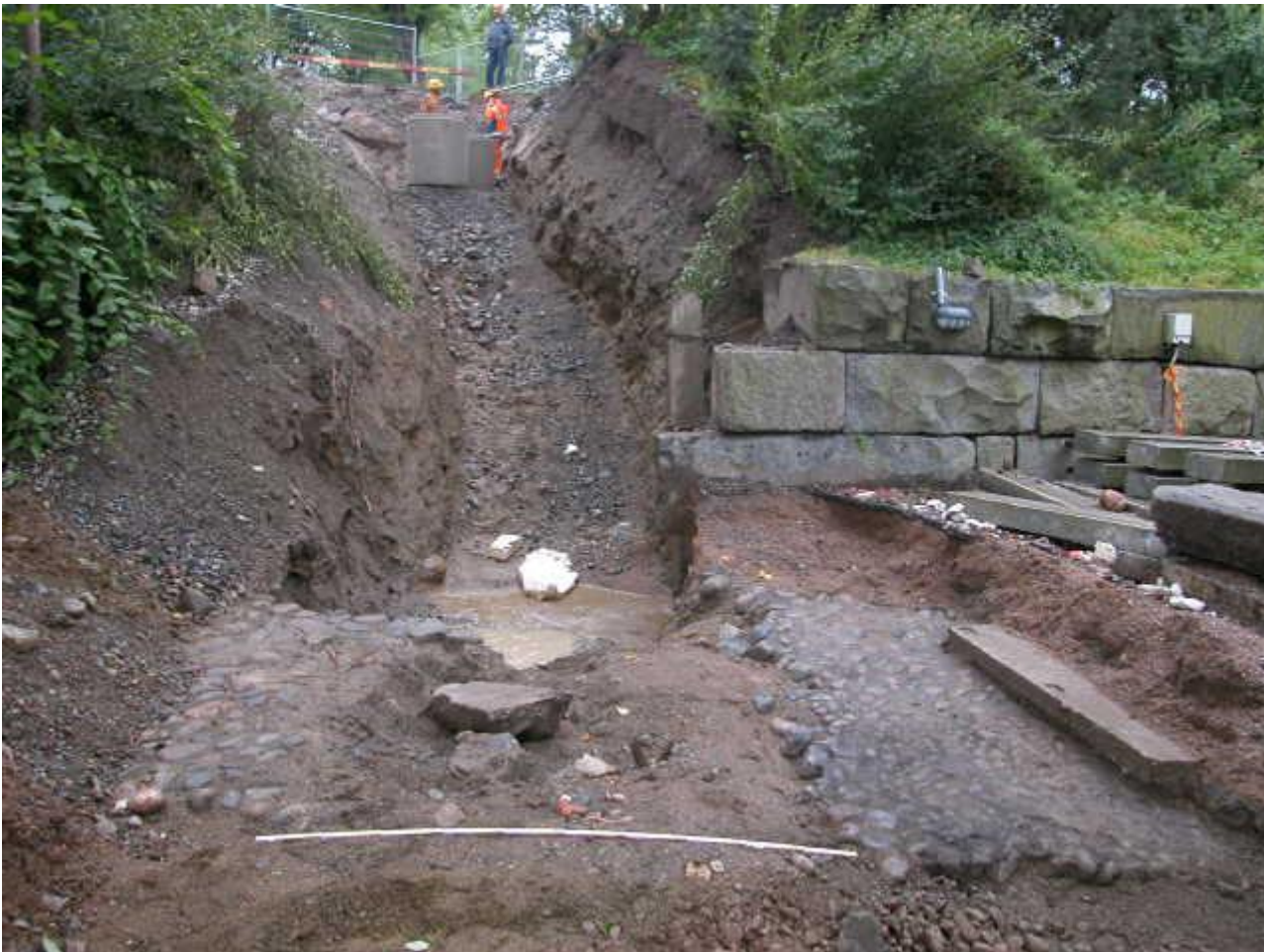
Kuva 33: Yleiskuva F-alueesta. Kuvassa edustalla kenttäkiveys, jonka halki kulkee kiveyksetön (purettu?) kaistale. Kiveyksettömällä alueella erottuu kaatunut ja särkynyt betonijalusta alkuperäisellä paikallaan. Oikealla puolella erottuu kiveyksen päällä betonilaatta. Taustalla tukimuuria, päivämäärällä varustettu betonipylväs (ympyröity) ja rinne, josta porraskivet on poistettu ja portaiden kohtaa kaivettu. Mittakaavana 2 metrin nivelmitta. Kuvattu lounaaseen. Kuvaaja: Sami Raninen
