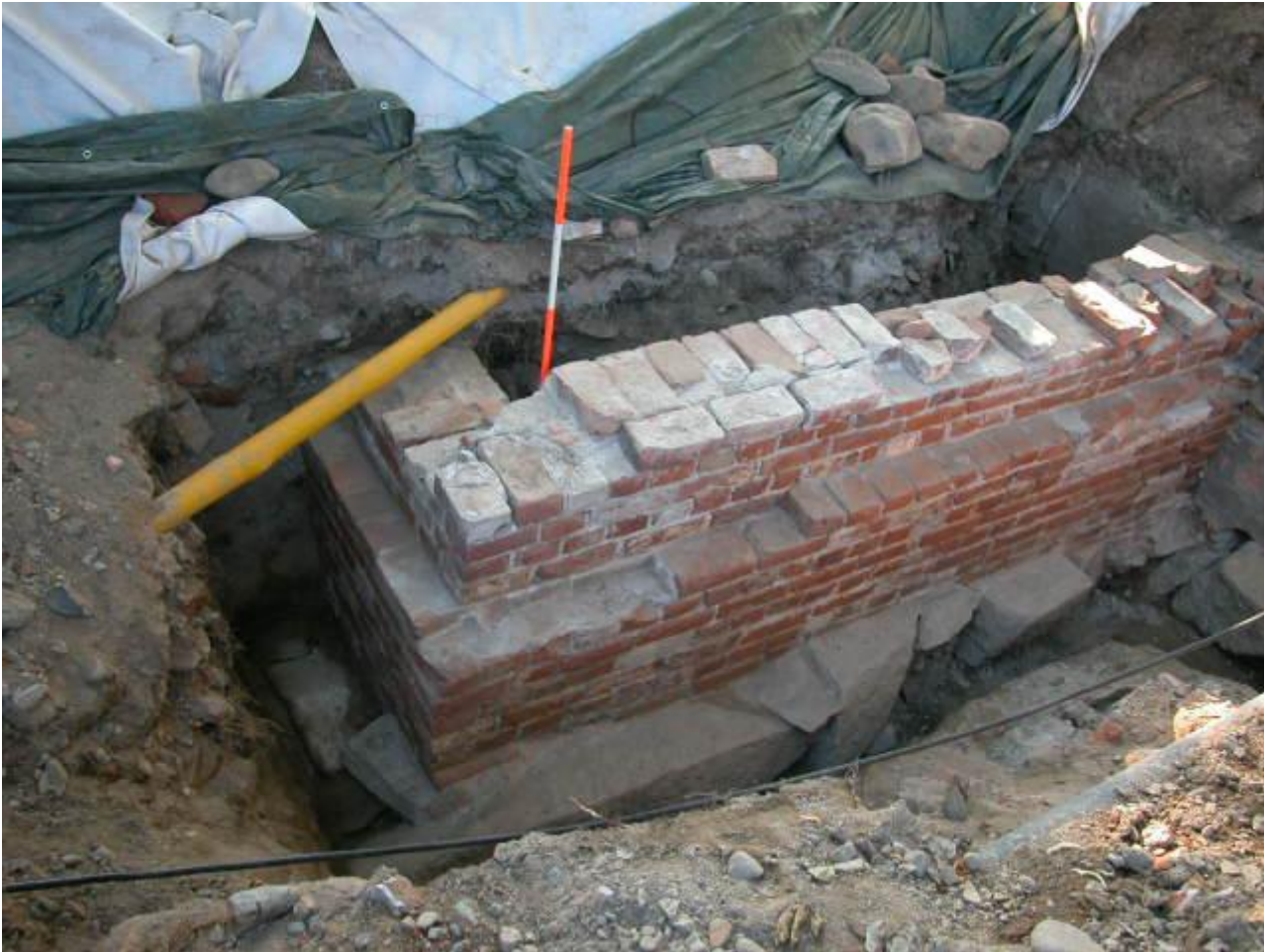
Kuva 31: Tiilimuri yläviistosta ja kaakkoon päin kuvattuna. Muurin kivisokkeli näkyy selvästi. Mittakaavana teikki (värit vuorottelevat 30 cm:n välein). Kuvaaja: Sami Raninen.
