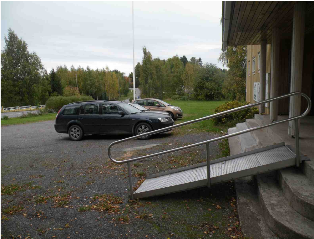
Vesilahden seurojentalon itäpuolista piha-aluetta kuvattuna pohjoisesta. Silmämääräisen arvion perusteella kuvassa taustalla erottuva nurmikentän alue on tasattu ja paikalle on tuotu maata runsaasti. Kirsi Luoto 28.9.2011
