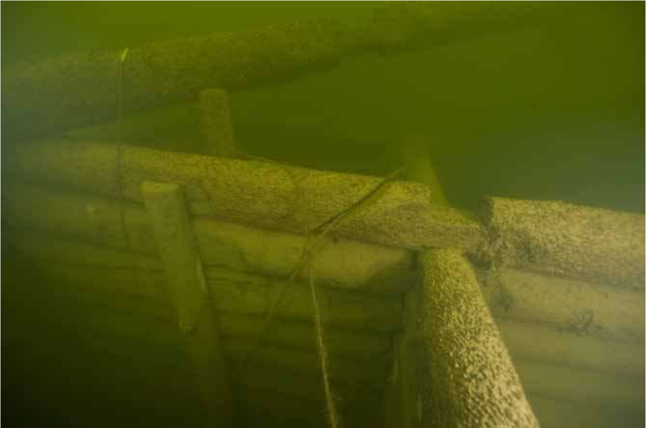
Yllä (MA201016: 17) Tykistölahden hirsiarikkupato yläviistosta, alla (MA201016:20) hirsiarikkupadon seinämää meren pohjan tuntumassa. Kuvaaja: Petri Puromies.
