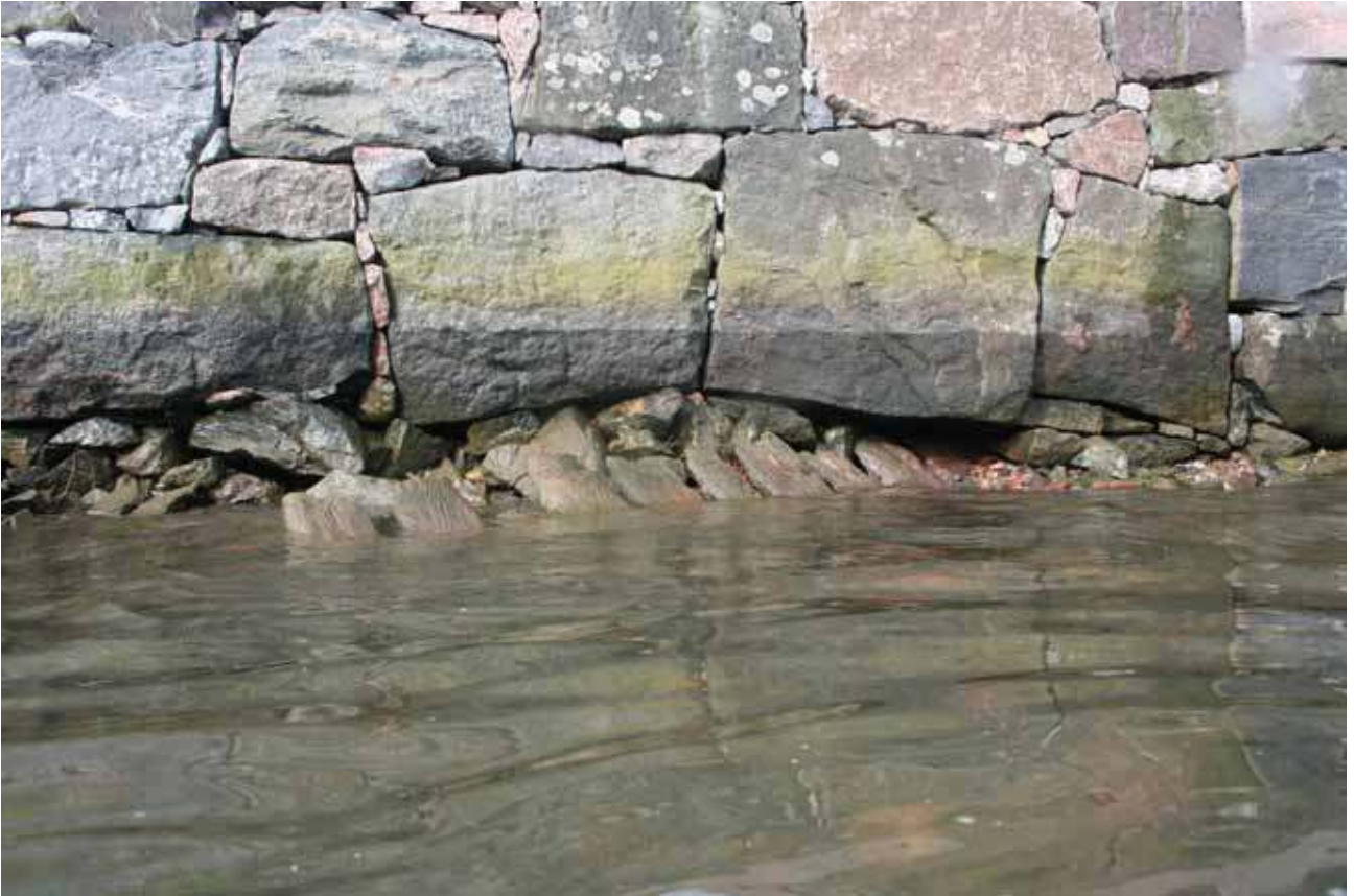
Yllä (MA200909:40) puurakenne jatkuu muurikiveyksen alle, alla (MA200909:36) yksityiskohta puurakenteesta. Kuvaaja: Minna Leino
