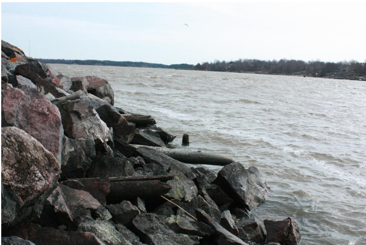
Kuva 5. Laiturirakenteita. Kuvaussuunta itään.. Kuva: Minna Leino
