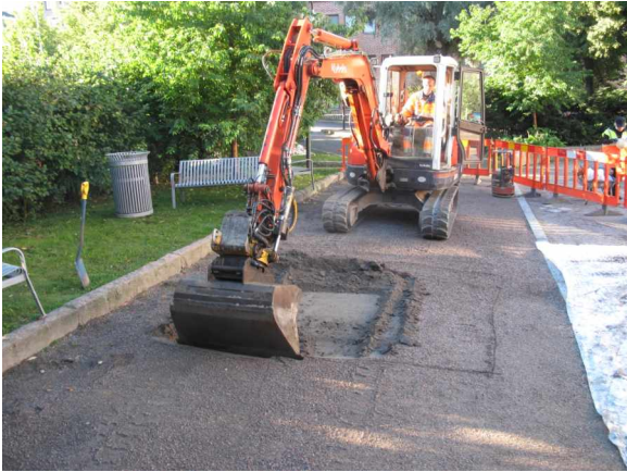
Kuva 18. Koekuoppa 5:n avaaminen. Kuvattu pohjoisesta.
