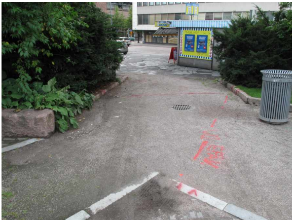
Kuva 3. Koekuoppa 2:n suunniteltu alue. Koekuopan kaivun estivät alueella olevat vesi- ja sähköputket, jotka on merkitty maahan. Kuvattu koillisesta.
