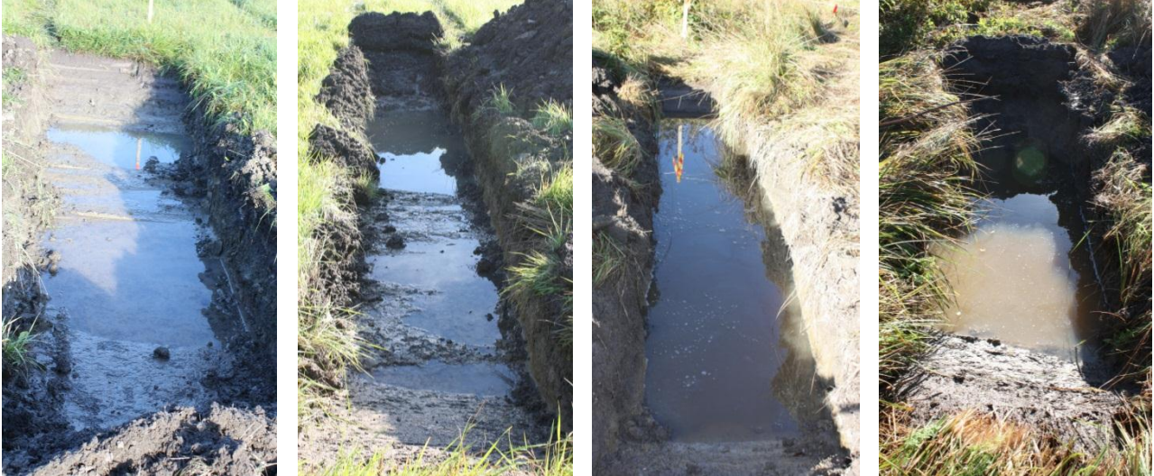
DG2706:10–13 Koeojat 6–9 pohjaan kaivettuina. Ojat ovat jo täyttyneet osittain vedellä. SE-NW, W-E, E-W ja NW-SE. Kuvat Katja Vuoristo.
