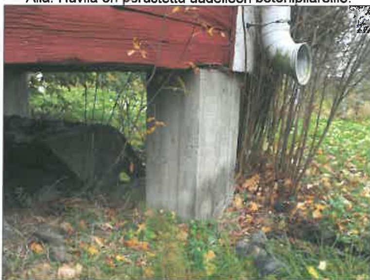
Alue jolle suunniteltu rakennusala sijoittuu. Kuvattu itään. Alla: Huvila on perustettu uudelleen betoniopilareille.
