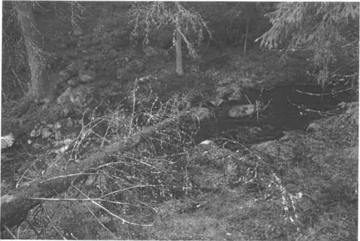
Kuva 20. Vihti Korpinkallio 6. Rakennuksen perustukset purossa. Kuvattu kaakosta luoteeseen 4.5.2010. (Kuva: M. A. Manninen)
