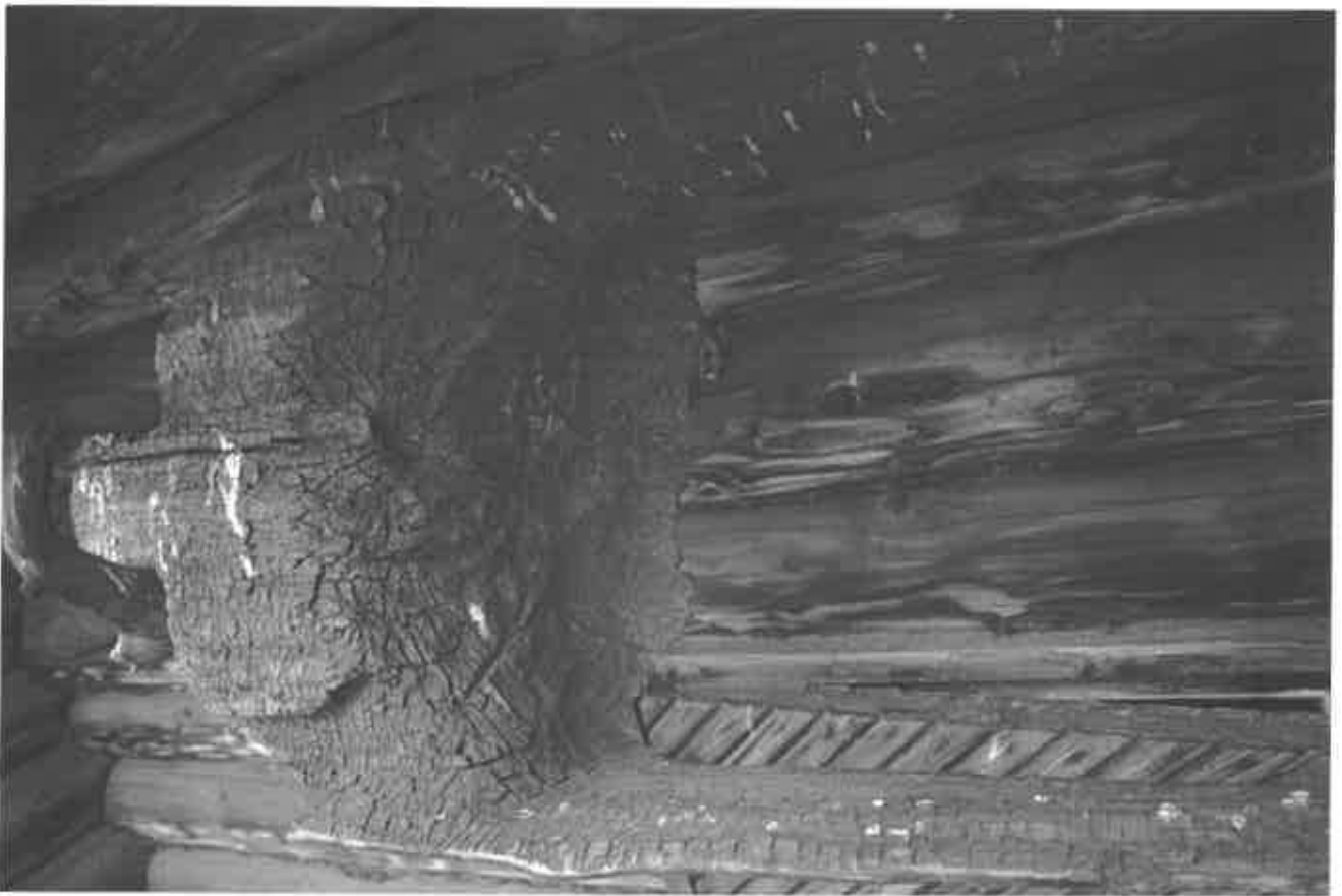
Kuva 8. Vihti Kolmikulmalampi. Ruuhin sisäpinnalla näkyviä veistojälkiä 7.5.2010. (Kuva: M. A. Manninen)
