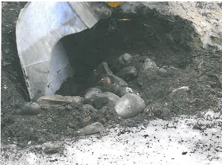
Kuva 44. Kenttäkiveystä rikotaan puistovalon perustuksen takia. Kuvaussuunta N.
