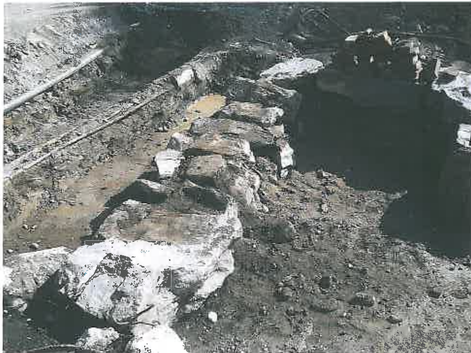
Kuva 30. Tiilimuuraus poistettuna. Kuvaussuunta W.
