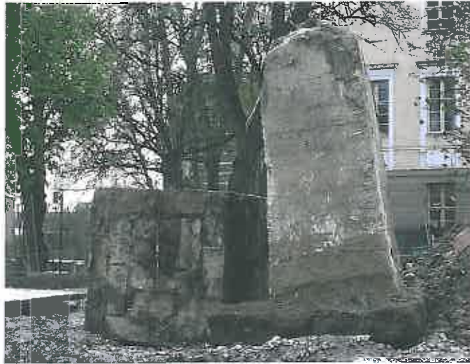
Kuva 47. Sadevesikaivo ja puistovalon sementtiperustus poistettuna.
