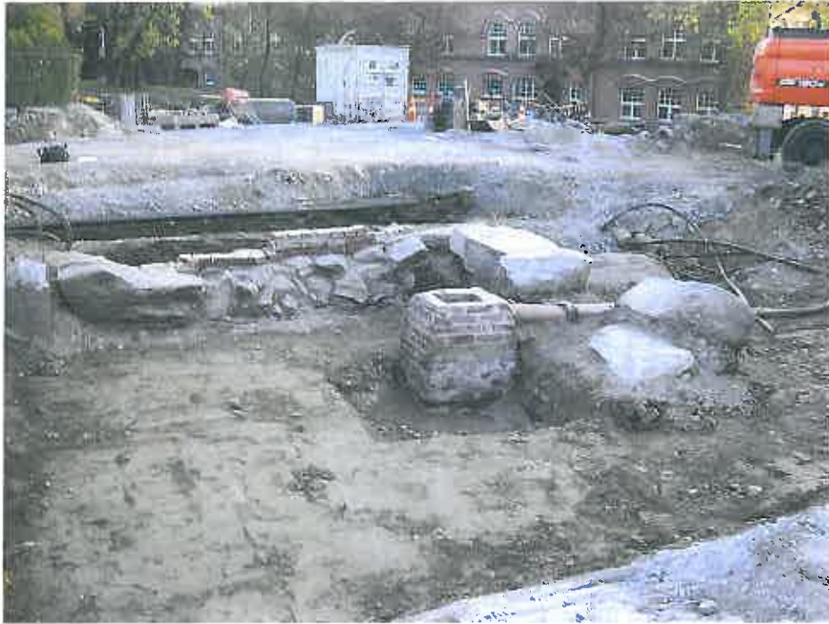
Kuva 5. Esiin kaivettuja rakenteita sekä katkaistuja ja katkaisemattomia kaapeleita. Kaivetun alueen yläreunassa, mustan muoviputken takana on alue, johon kaivettiin Ranisen valvonnassa vuonna 2010 viemäri- ja vesijohtoputket. Kuvaussuunta N.
