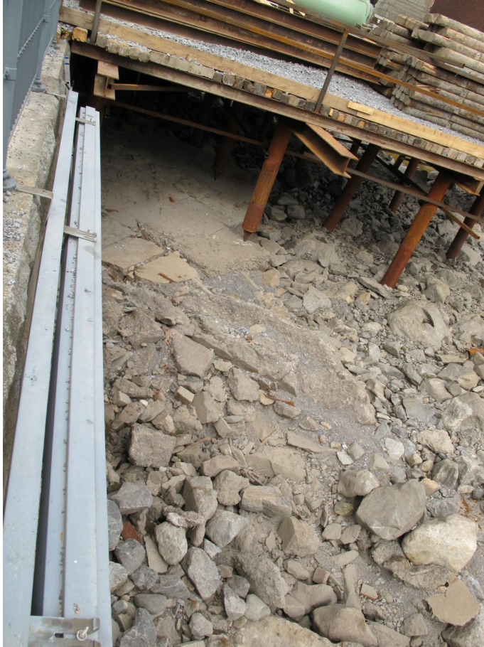
Kosken pohjan kivilaattoja Frenckellin ja voimalaitoksen välissä länsirannalla etelästä (rakenne 4 C). Kuitunen Hannele
