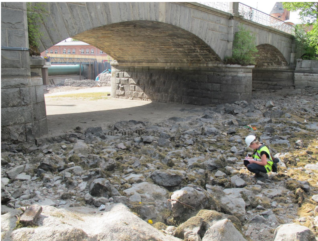
Satakunnansillan pohjoispuolen ja rantapenkan kulma puurakenne pohjoisesta. Hannele Kuitunen
