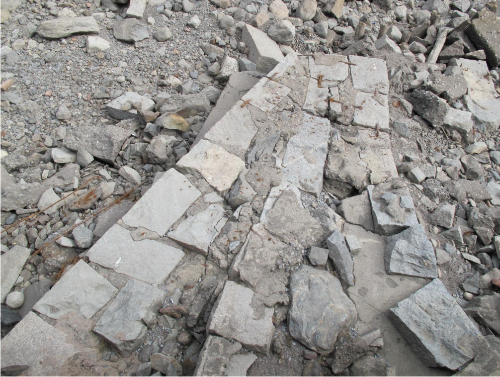
Vesikanavarakenteet länneestä rakenne 4A. Kuitunen Hannele
