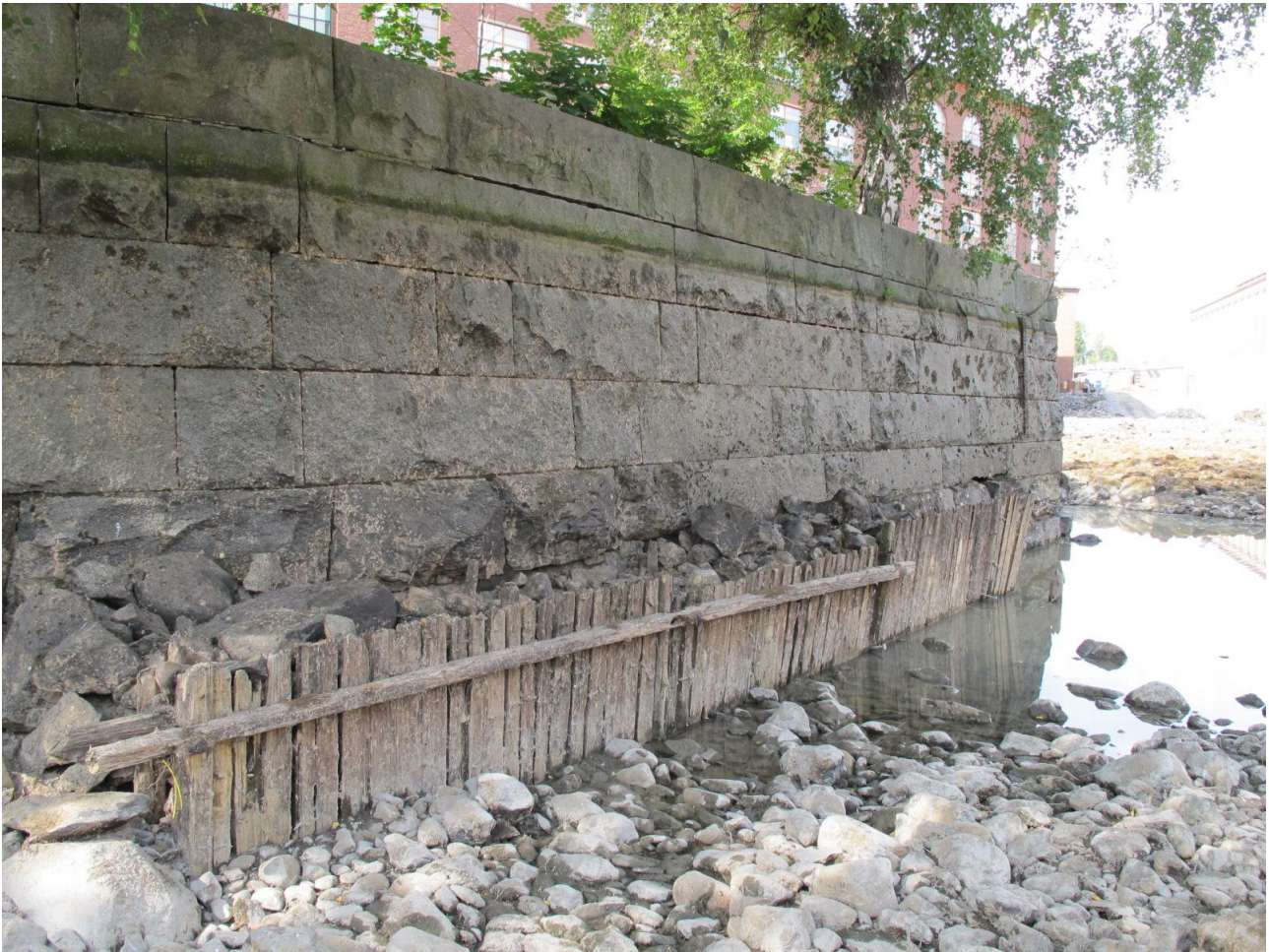
Konsulinsaaren koillisreunan muurin tukiarkkurakenne (3A) kaakosta.jpg Hannele Kuitunen
