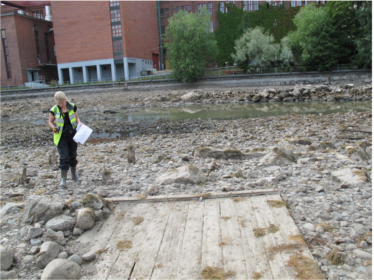
Kosken keskiosan puurakenne; puulattiarakenne 8B idästä. Kuitunen Hannele
