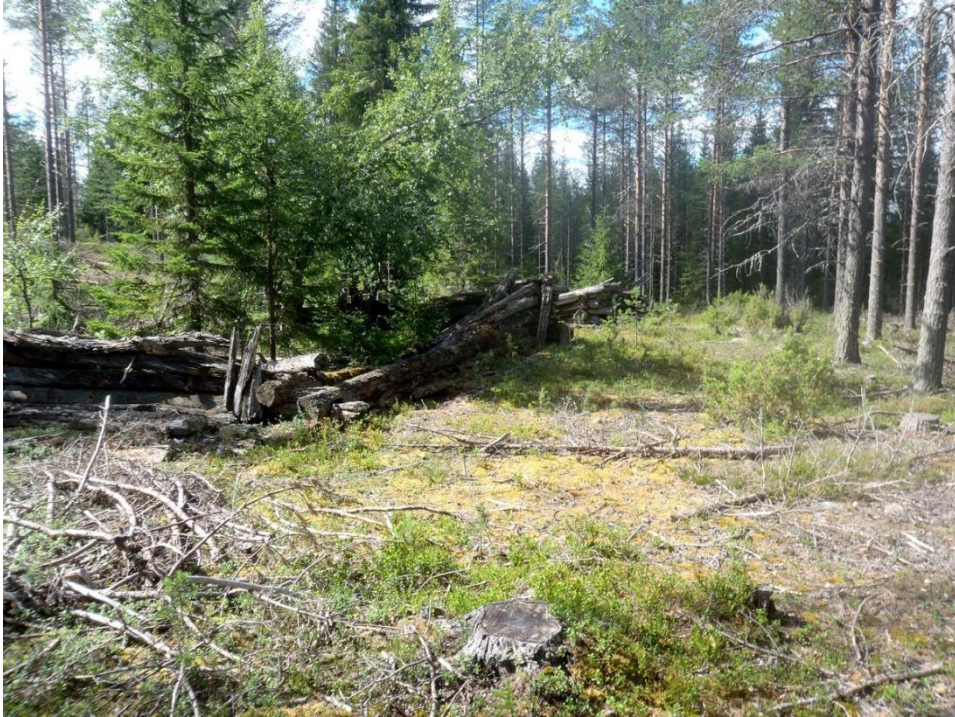
Tallin jäännös (rakennus 3) itäkoillisesta.
