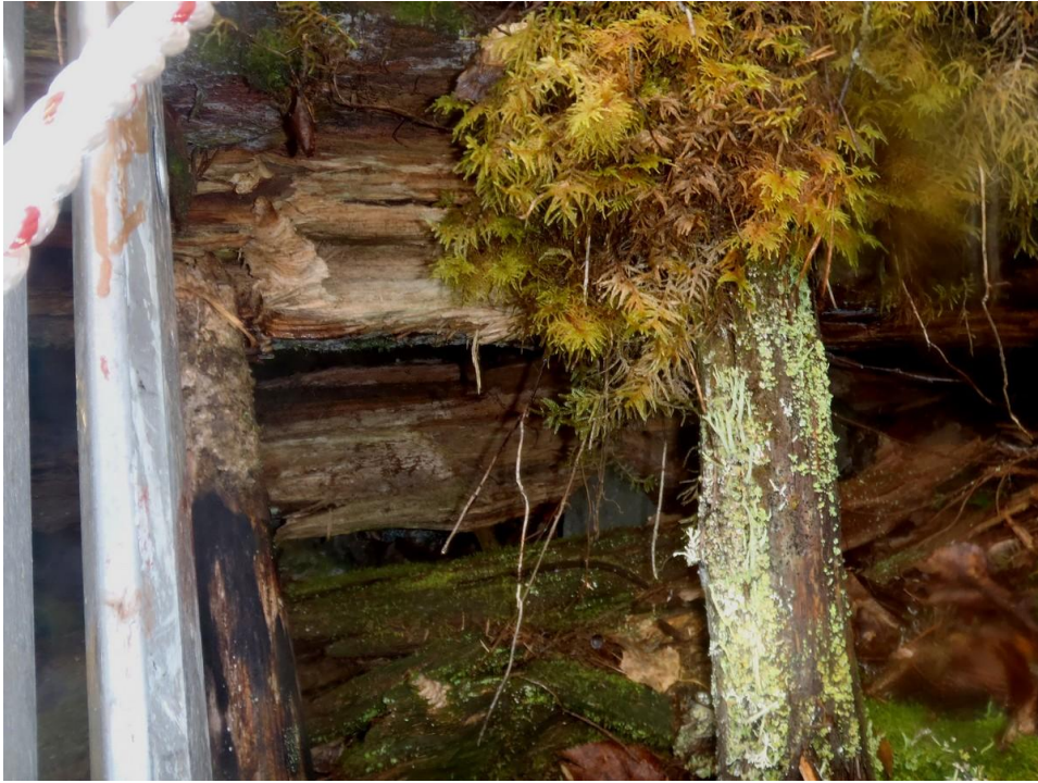
Puiset tukirakenteet kuilun yläosassa.
