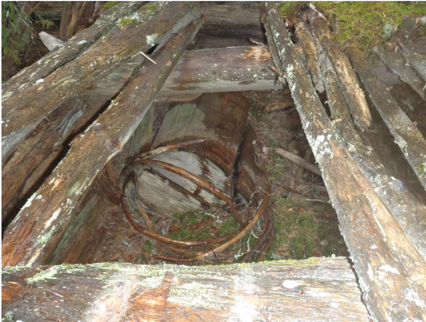
Rakennus 1 itäosa, sisäkuva. Tervatynnyrin jäänteet.
