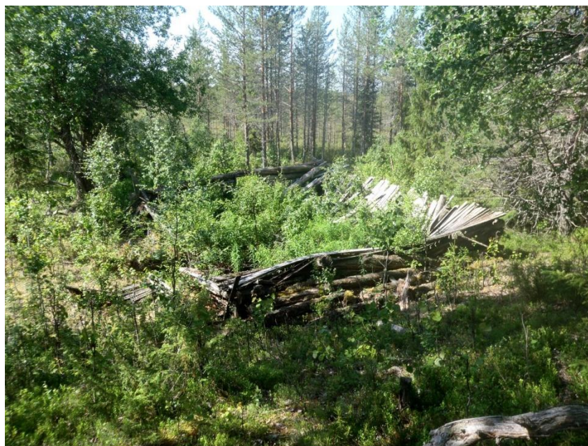
Rakennus 1, yleiskuva koillisesta.
