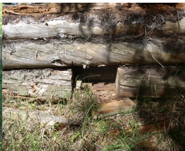
Rakennus 2, luukku takaseinässä.
