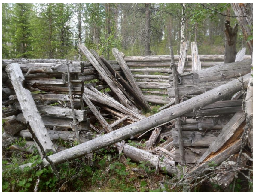
Lähikuva eteläseinän aukosta.
