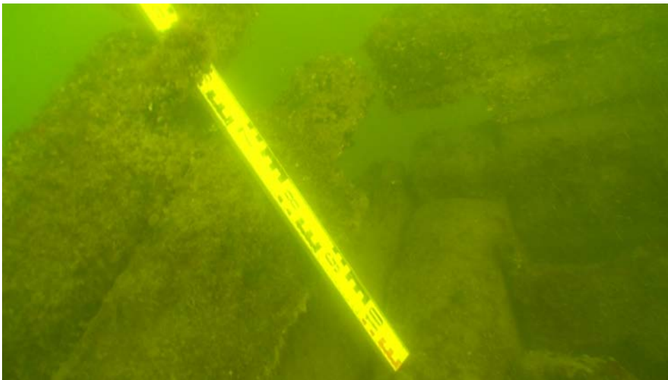
Kuva 57. Auennut kulmaliitos. Kuva Rami Kokko.
