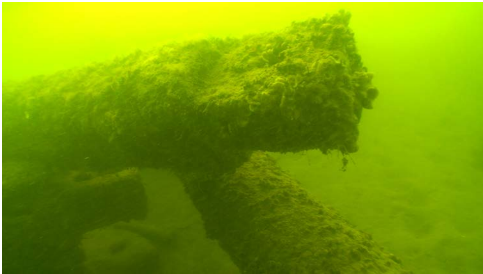
Kuva 59. Pyöröhirren lyhyt nurkkasalvos. Kuva Rami Kokko.
