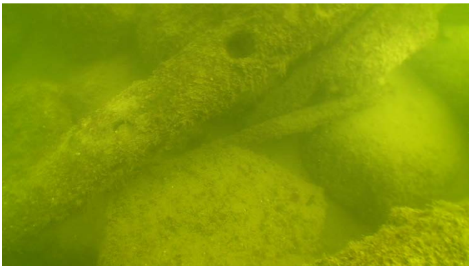
Kuva 60. Pyöreitä luonnonkiviä arkkurakennelman sisällä. Kuva Rami Kokko.
