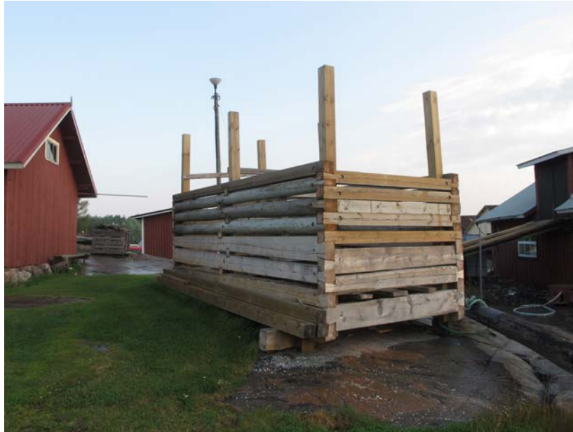
Kuva 61. Paraisten Borstöissä syyskuussa 2012 kuvattu rakenteilla oleva hirsiarokku. Kuva Aki Leinonen.
