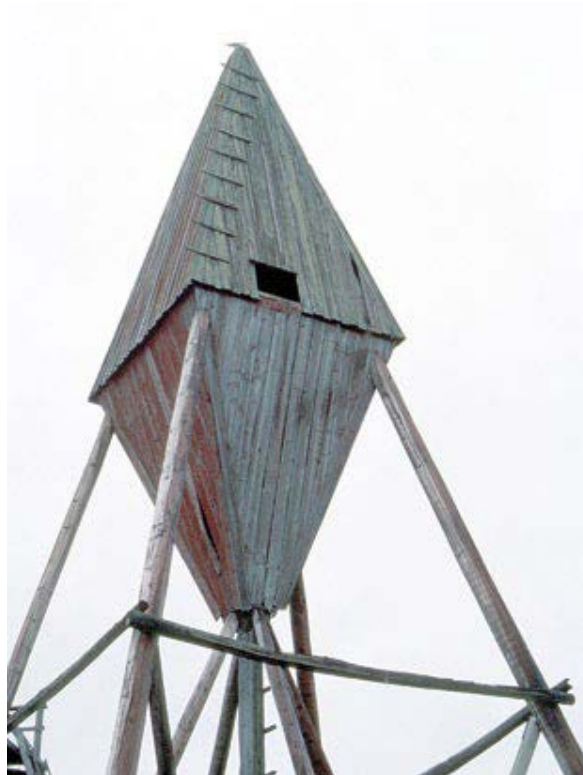
Kuva 64. Korsnäsin Svetgrundin sauvarakenteinen merimerkki on ainoa suurikokoinen jäljellä oleva sauvamerkki. Nyman 2009: 8.
