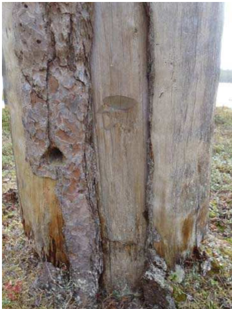
Pohjoissivun pilkka koillisesta.
