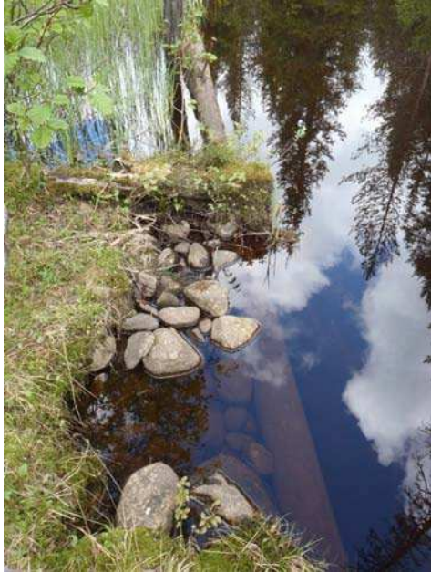
Sillan tukirakenteita kuvattu etelästä.
