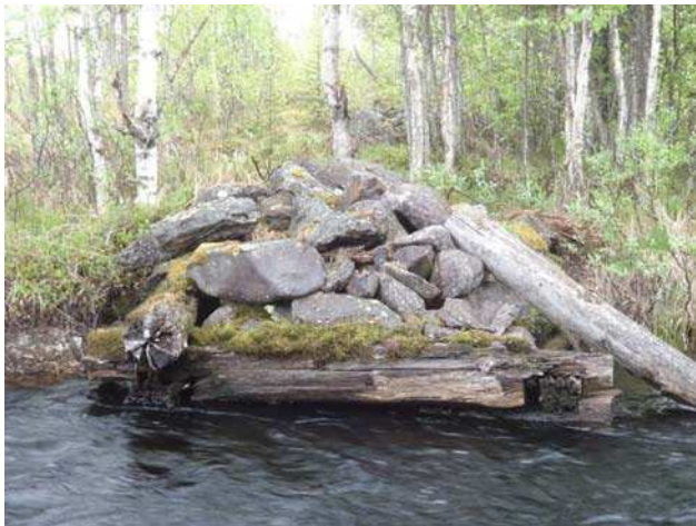
Itäpuolen patojäännös kuvattu lännestä.
