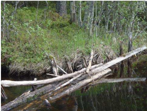
Yksityiskohtakuva padon pohjoispään rakenteista, etelästä.
