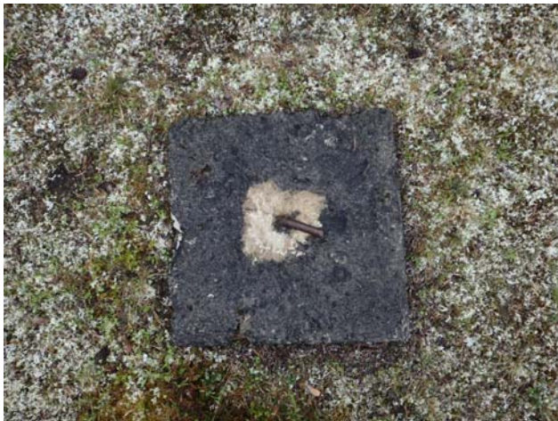
Lähikuva betonisesta tukirakenteesta.
