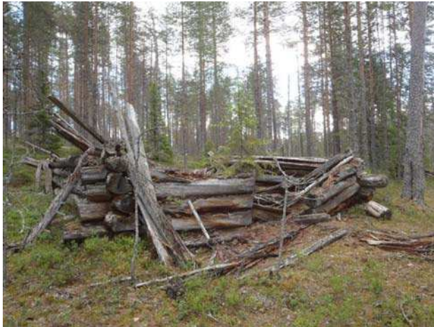
Rakennus 1, yleiskuva luoteesta.
