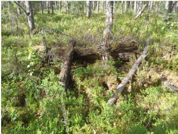
Rakennus 1 lounaisseinä, kuvattu etelästä.
