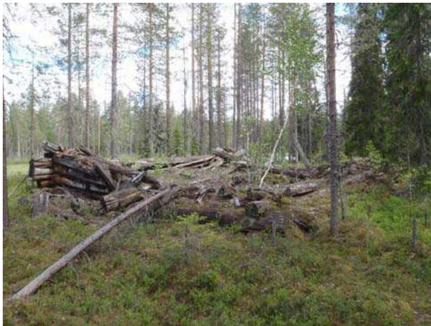
Rakennus 1 yleiskuva luoteesta
