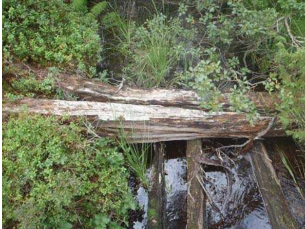
Yleiskuva rakenteista idästä.
