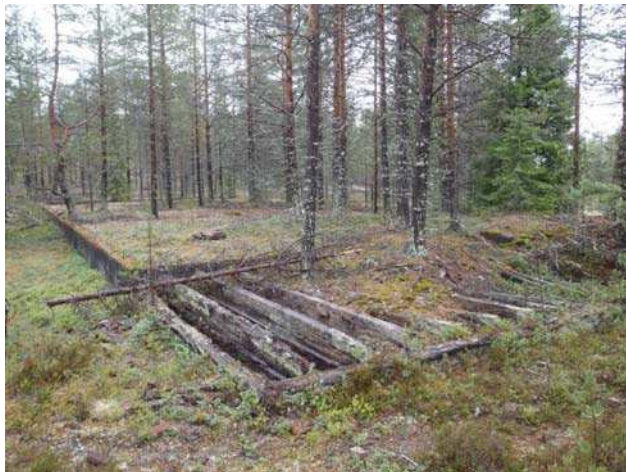
Yleiskuva rakennuksen jäänteestä lounaasta.
