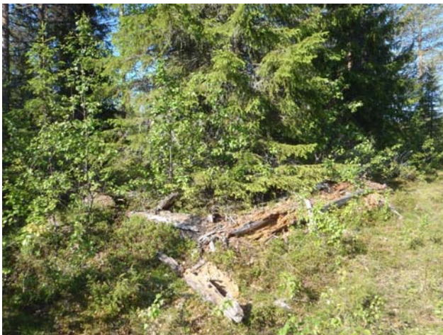
Rakennus 1 yleiskuva koillisesta
