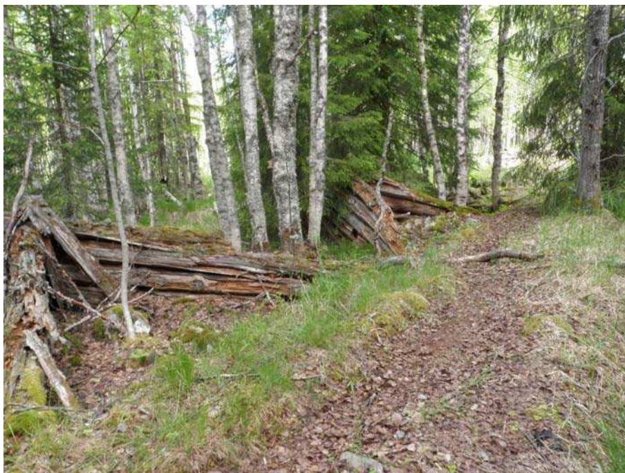
Hirrestä tehdyt tukirakenteet maavallin länsipuolella.
