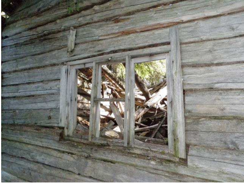
Lähikuva pohjoisseinän ikkunasta.
