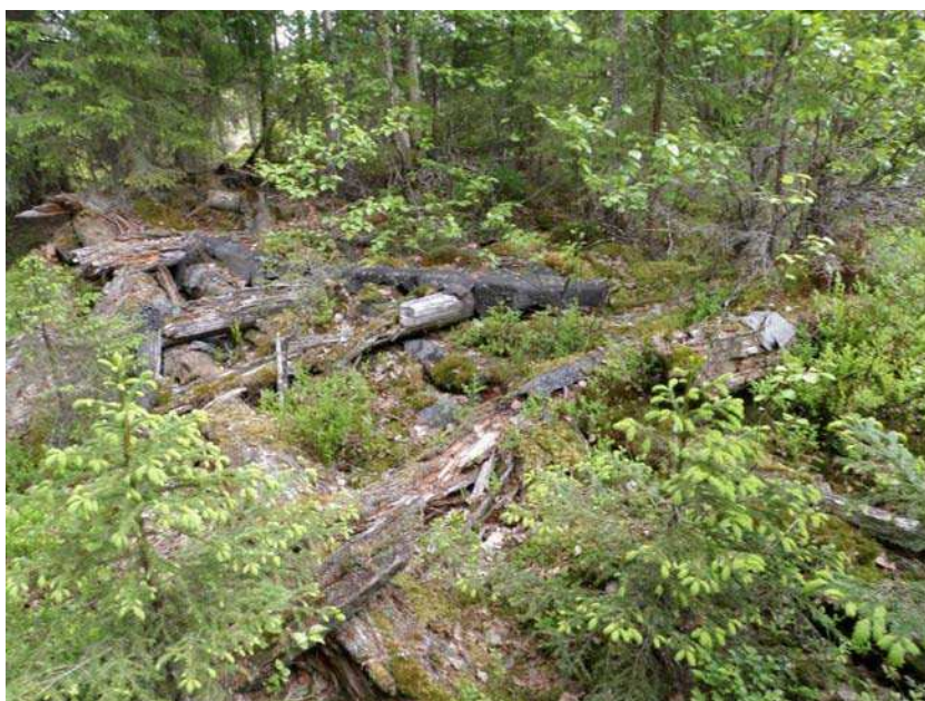
Rakennus 1 jäännös länsipääty kuvattu lounaasta.
