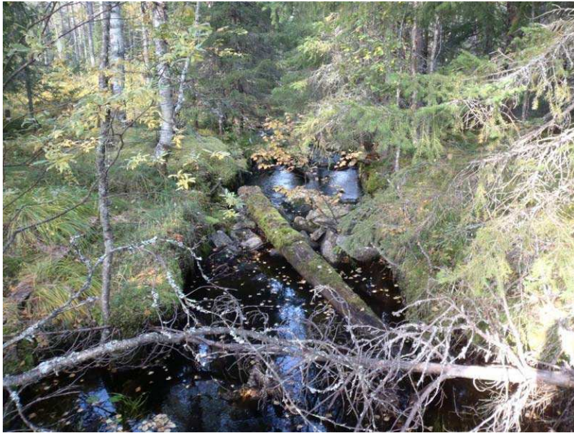
Kuva sillasta idästä.
