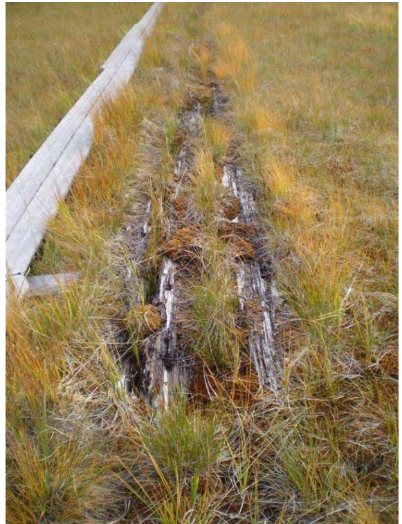
Lähikuva pohjoisesta (R.-V. Vaske)
