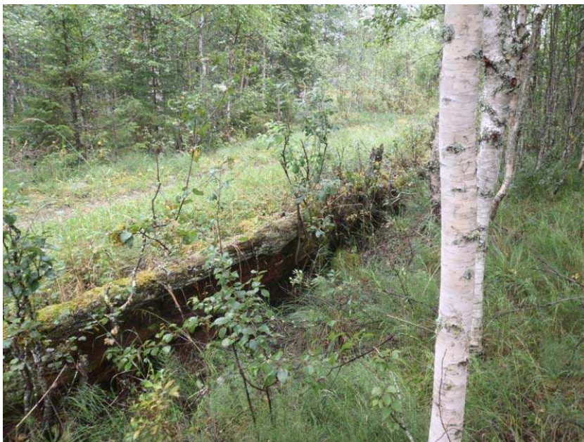
Padon tukirakenteet kuvattu lounaasta.
