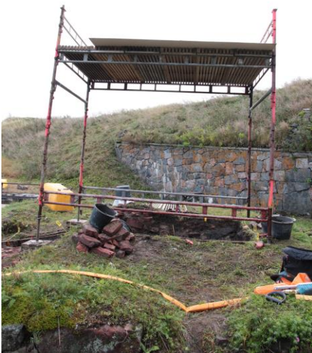
DG 2818:12 Kuvassa sateensuojana toiminut rakennusteline. W-E. Kuva Verna Kalmari.
