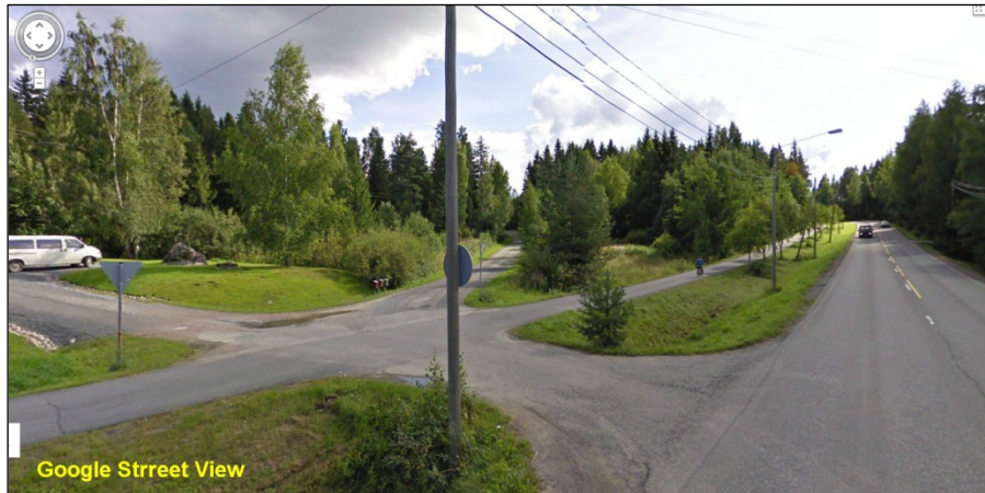
Vanhan tielinjan pohjoispäätä – Orkontien ja Tampereentien risteys. Etelään.
