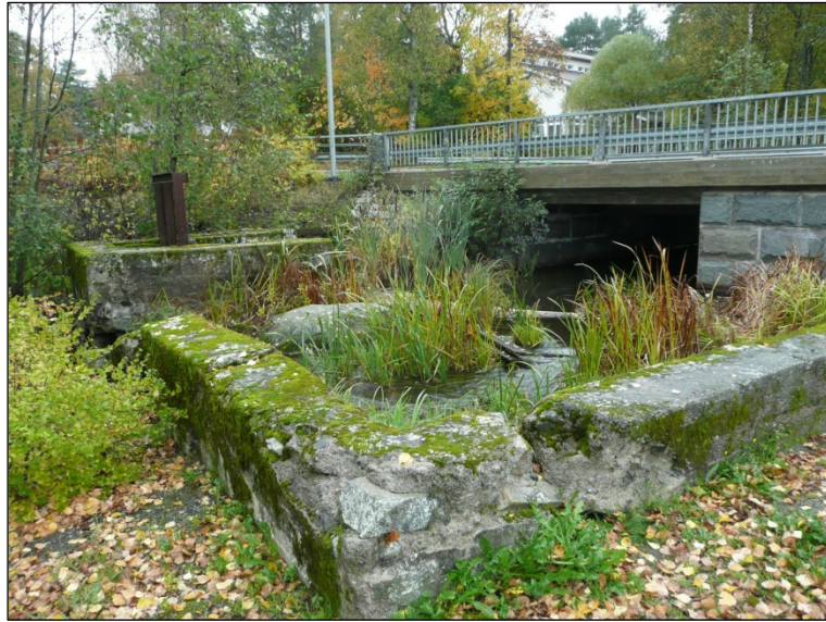
Betonirakenteita sillan eteläpuolella
