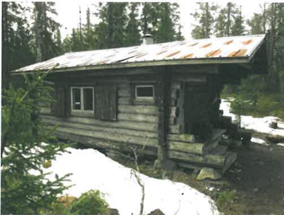
Kuva 14. Louevaaran autiotupa. Kuvattu pohjoisesta.
