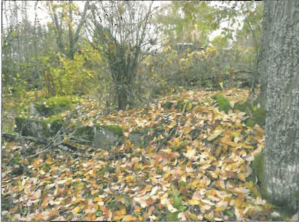
Tupurla: Rakennuksen perusta.
