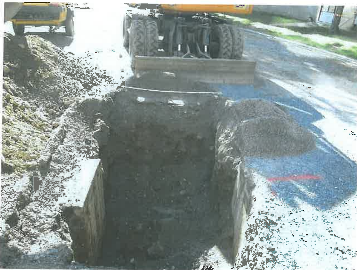
Kuva 6. Koekairauspisteen 7 kohdalla esille tulleet betonirakenteet. Mittakaavana 2 metrin nivelmitta. Kuvattu etelään. Kuvaja: Sami Raninen.
