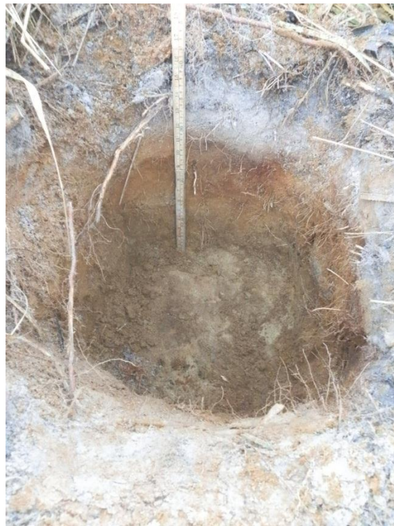
Kuva 8. Koekuoppa 3 pohjaan kaivettuna. Kuvat: Jouko Pukkila.
