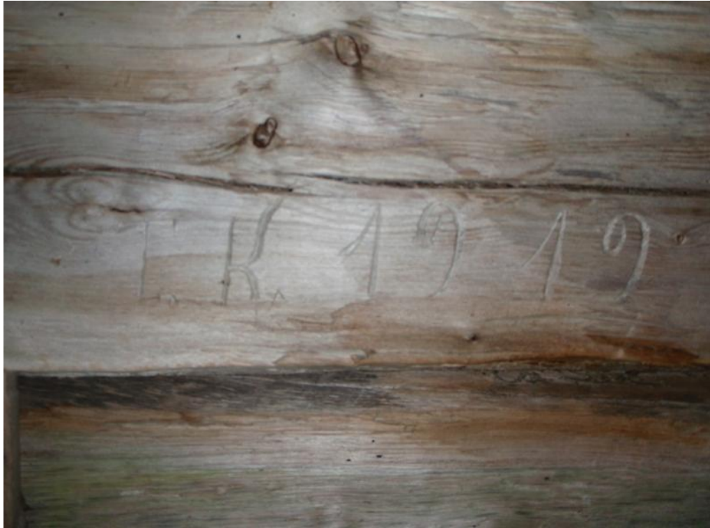
Kuva 107. Hangaskuru 1, niittylato. Kaiverrus ladon sisällä, oviaukon yläpuolella: T.K. 1919. Ilmeisesti vanhin kaiverrus. Kuvattu etelälounaasta.
