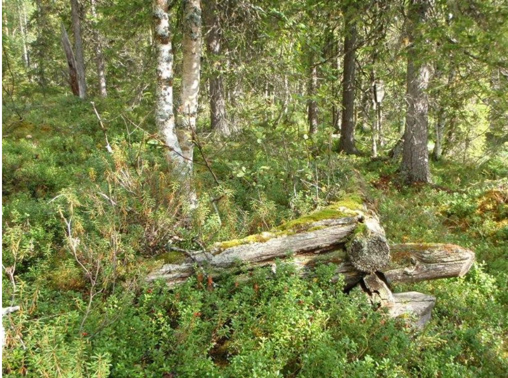
Kuva 80. Kesänkijärven pohjoisranta. Rakennuksen jäännös 2:n lounaisnurkan rakenteita, koirankaulasalvoksia. Kuvattu lännestä.
