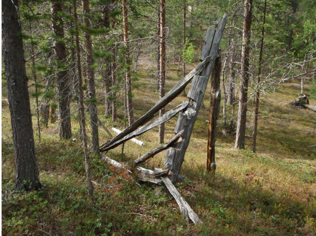
Kuva 169. Ounastunturin rengasaita. Kohtalaisen hyvin säilynyt aidan tolppa poikkipuineen Ahvenjärvenharjujen alueella. Kuvattu kaakosta.
