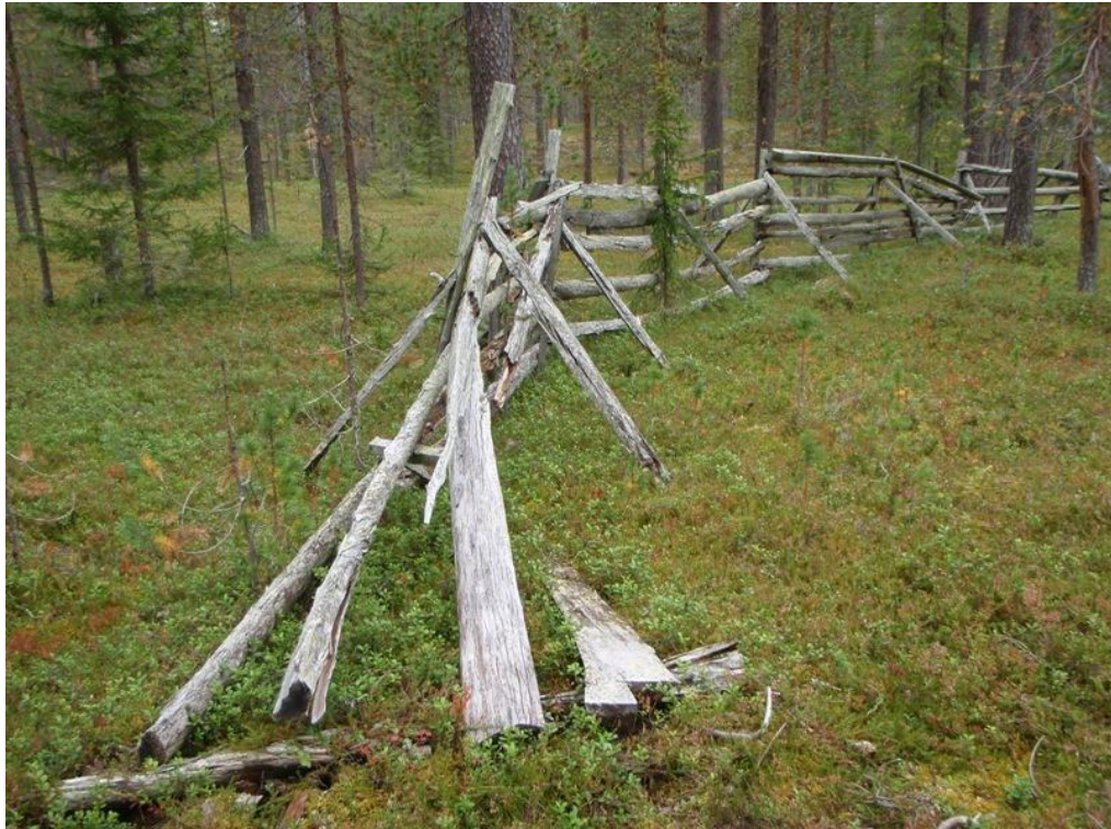
Kuva 159. Nilivaaran poroerotusaita. Ohjasaidan jäännöksiä. Rakennettu halkaistuista mäntysoiroista tehdastekoisilla nauloilla. Kuvattu kaakosta.
