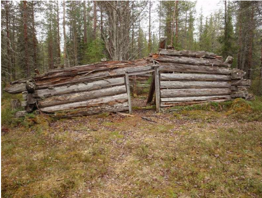
Kuva 24. Kämpä 1. Kuvattu pohjoisesta.
