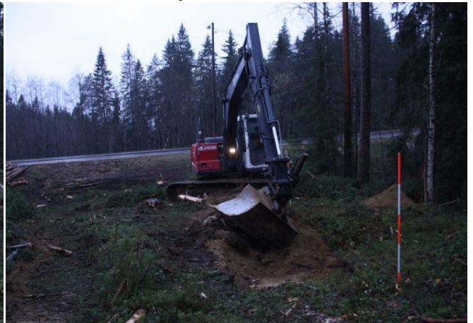
DG2712:6. Työkuva. Kaivinkone avaamassa kuoppaa 3. Länteen. Kuvaaja: Mikko Suha.
