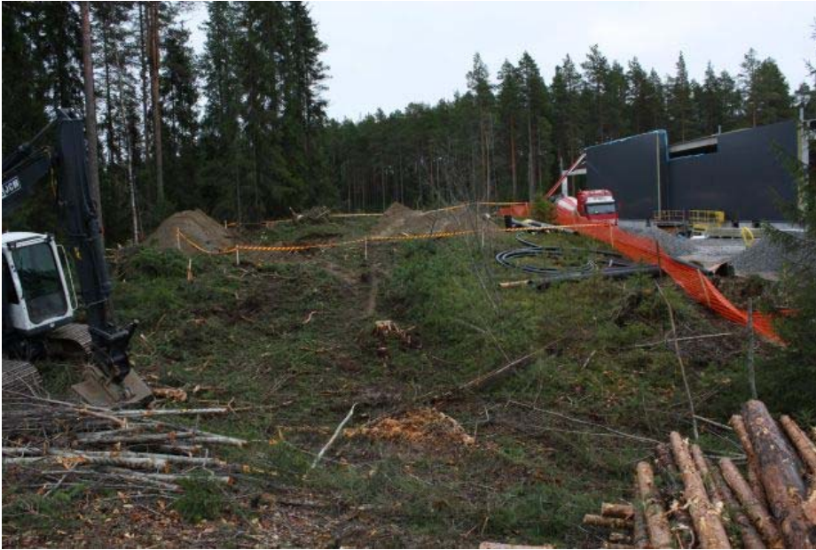
DG 2712:14. Yleiskuva. Kuopien ympäristö rajattiin huomionauhalla varoitukseksi ohikulkijoille. Itään. Kuvaaja: Mikko Suha.
