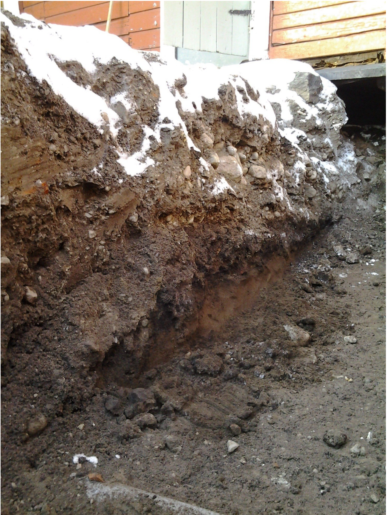
Kuva 4. Alue 4 koillisesta. (K.Uotila)
