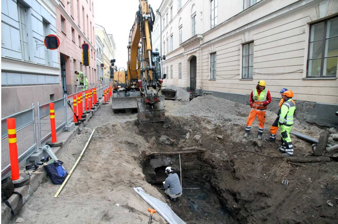
Heini Hämäläinen dokumentoi Katariinankadun 1800-luvun jälkipuoliskon harmaakiviputkiviemäriä.
