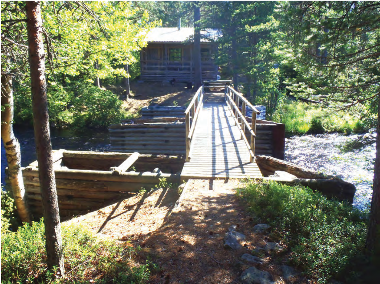
Kukkurin tammi Peurokoskessa. Tammen yli kulkee nykyään retkeilyreitän silta. Takana Kukkurin uittokämpä, joka toimii nykyään autiotupana. 2507.143.jpg.
