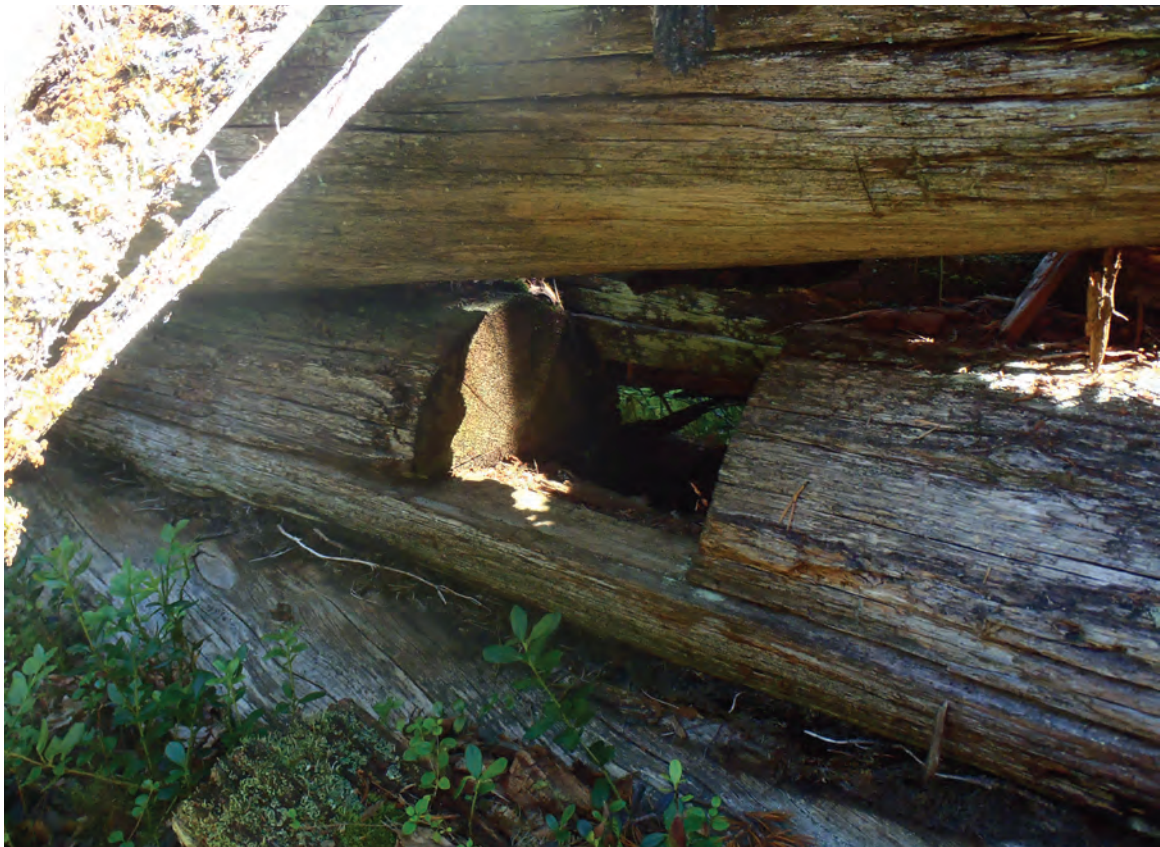
Rakennuksen seinässä oli jäljellä vielä tuuletusräppänen paikka. 2607.198.jpg.
