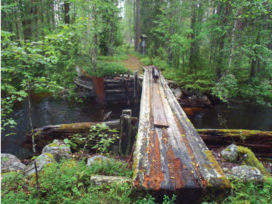
Yllä: Pikku Tolosenvirran pohjoisempi uittopato, jonka yli kulkee nykyään retkeilyreitit silta. Vahvat hirsiaarkut kivitäytteenä ovat tukeneet patoa. P8070230.jpg.
