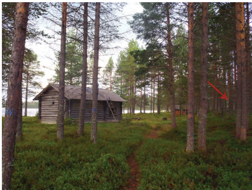
Etualalla Lavajärven savusaunasta kunnostettu nykyinen autiotupa. Nuoli osoittaa tallin raunioita, joiden takana on kämpän pohja. P8060168.jpg.
