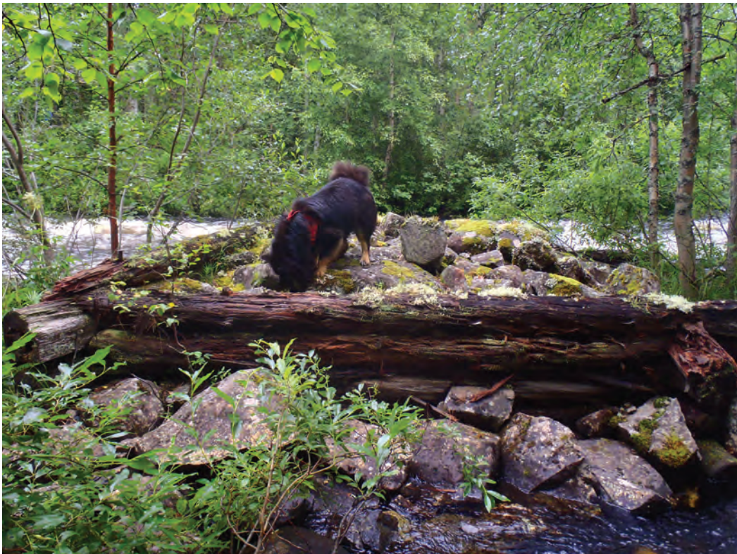
Lounatkosken rannan suisteita oli tuettu hirsillä arkuilla, joissa oli täytteenä kiviä. P8070214.jpg.
