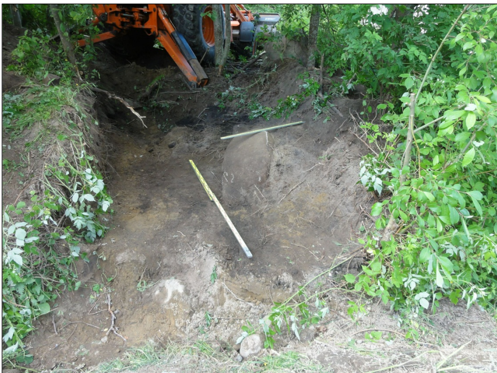
Kuva 5.Koeojan 1 laajennus luoteeseen. Kuva: Antti Bilund
