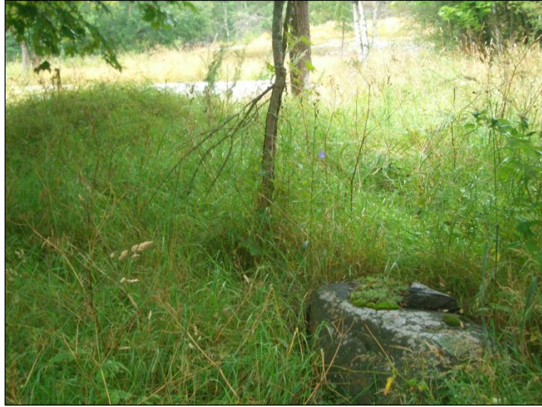
Älgsjö. Rakennuksenjäännös 1. Kuvassa kivistä perustusta.
